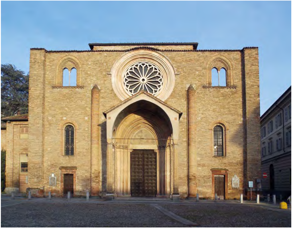
2: Lodi, Tempio di San Francesco, facciata [Fotografia dell'autrice].
