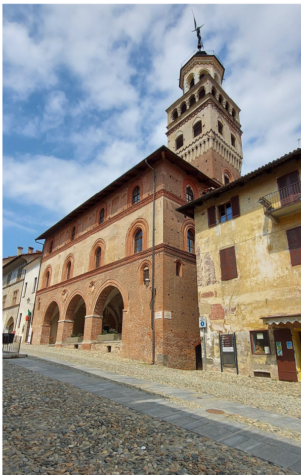
10. Salita al Castello : estado actual del Antiguo Palazzo Comunale y de la Torre
