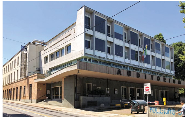
fig. 2 – L'Auditorium RAI Arturo Toscanini, stato di fatto al 2020 (fotografia dell'autore).
