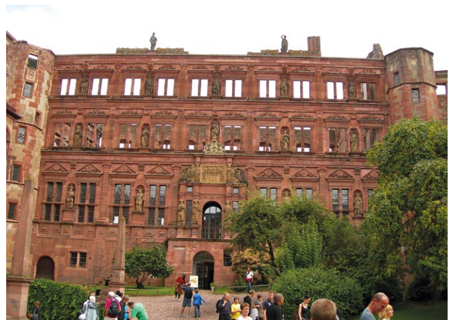
fig. 10 – Heidelberg: le rovine del castello che rappresenta uno dei simboli della città e mostra un interessante intervento di conservazione integrata con funzioni ricettive, museali e turistiche.
