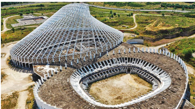
fig. 12 – Roma: la Città dello sport, commissionata dall'Università di Tor Vergata all'architetto Santiago Calatrava, e mai completata. Essa rappresenta un eccezionale caso di rovina che merita di essere tutelata, conservata e valorizzata anche solo come imponente rovina contemporanea.
