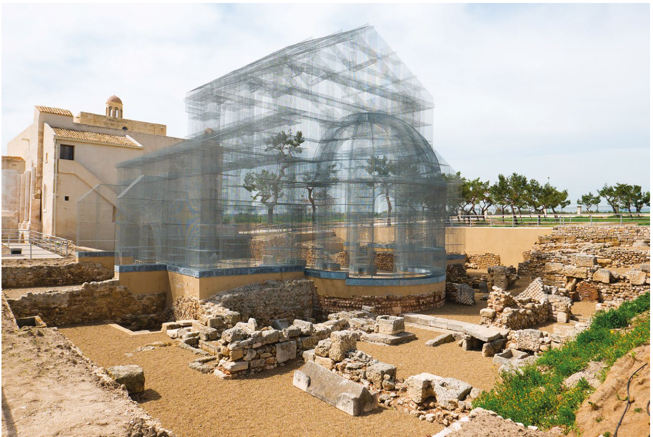
fig. 11 – Siponto: la basilica di Santa Maria dopo l'intervento di Edoardo Tresoldi che, sebbene abbia ridestato l'interesse verso il complesso cristiano, non valorizza appieno le rovine. Esse, infatti, appaiono mortificate dall'opera contemporanea, risultando marginali, così come le altre testimonianze archeologiche emerse di recente nelle immediate vicinanze.
