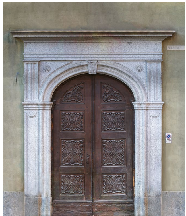
fig. 5 - Il portale del Seminario Diocesano di Acqui Terme, caso di specchiatura ottocentesca in granito bianco applicata ad una facciata eretta nel corso del XVIII secolo, qui riportata per completezza. Ortofoto, non in scala grafica, non in proporzione.
