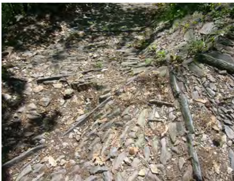
Figura 7 Soluzione di raccordo selciato a Ronco Canavese; Val Soana, (foto P. Scarzella).
