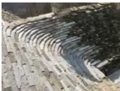
Figura 51 Piode di partenza per impluvio angolare. Balmella - Varzo (VB). Arch. Scotton.
