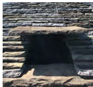
Figura 36 Vista frontale di varco di passaggio per ispezione esterna del manto. Cappella di Abramo - Sacro Monte di Ghiffa. Arch. Scotton.
