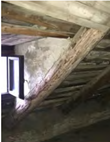
Figura 38 Abbaino. Dettaglio appoggio muratura su carpenteria.
