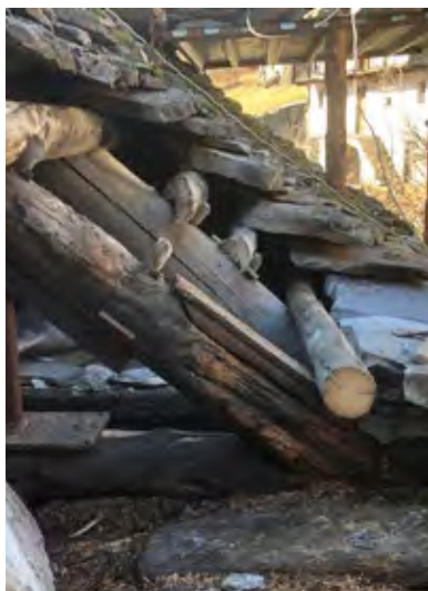
Figura 23 Manto monocorso. Balmella - Varzo (VB). Arch. Scotton
