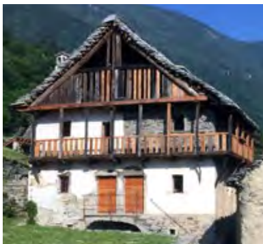
Figura 12 Loggiato con mensole sottoposte. Casa Gatti-Varzo. Arch. Scotton/ Saegesser
