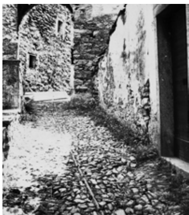
Figura 13 Acciottolato con linea d'impluvio in piede di coltello, Fondovilla, Anzino, Valle Anzasca.
