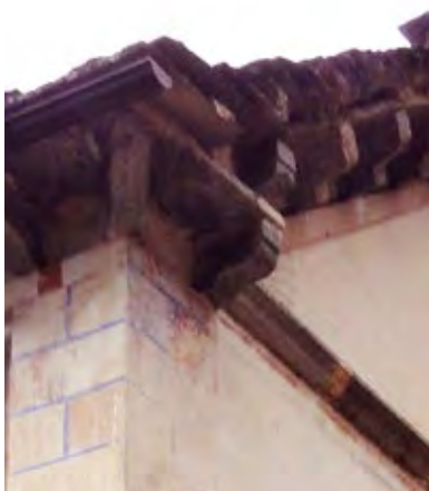
Figura 15 Gronda alla Romana. Oratorio Veglio - Montecrestese (VB)
