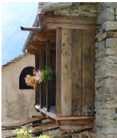
Figura 11 Loggia con mensole sottoposte. Veglio-Montecrestese (VB)
