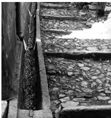
Figura 12 Gradonata acciottolata con canaletta di drenaggio lavorata alla punta fine, Canton Gorini, Vanzone, Valle Anzasca.
