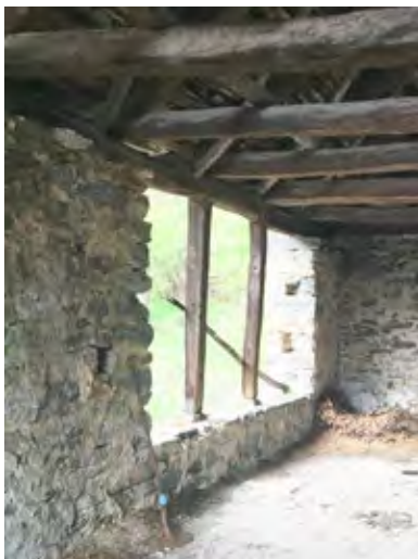
Figura 6 Vista interna di Astric. Dettaglio carpenteria. Fraz. Veglio - Montecrestese (VB)
