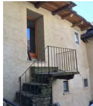
Figura 19 Vista inferiore di nuovi aggetti di gronda con mensole sottoposte. Trontano (VB). Arch. Scotton
