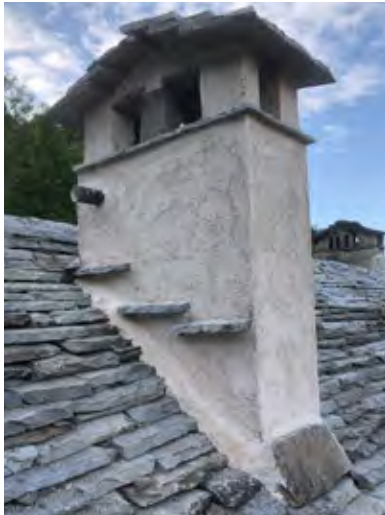
Figura 45 Camino in falda di nuova realizzazione.
