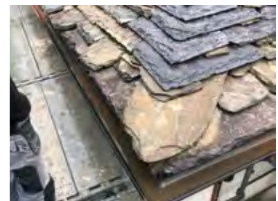
Figura 55 Fase di realizzazione di espluvio angolare. Cappella di Abramo - Sacro Monte di Ghiffa. Arch. Scotton
