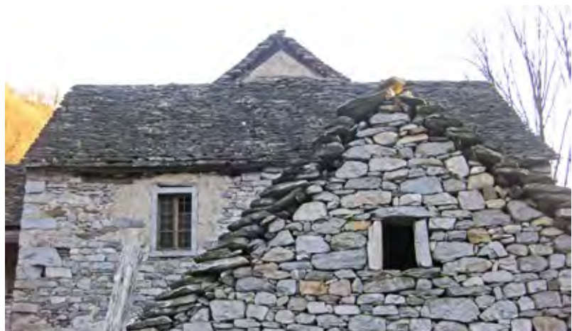
Figura 2 Ripresa di muro costruito a secco (in primo piano) e di muro con giunti di malta (in secondo piano) di due edifici di Veglio, frazione di Montecrestese.
