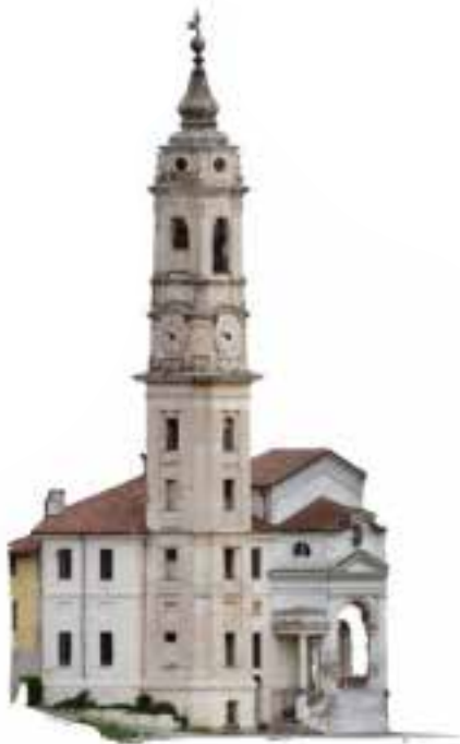
Figura 16. Montanaro. Campanile della ex casa comunale, scansione fronte sud (Laboratory of Geomatics for Cultural Heritage, Dipartimento Architettura e Design, Politecnico di Torino, 2020).
