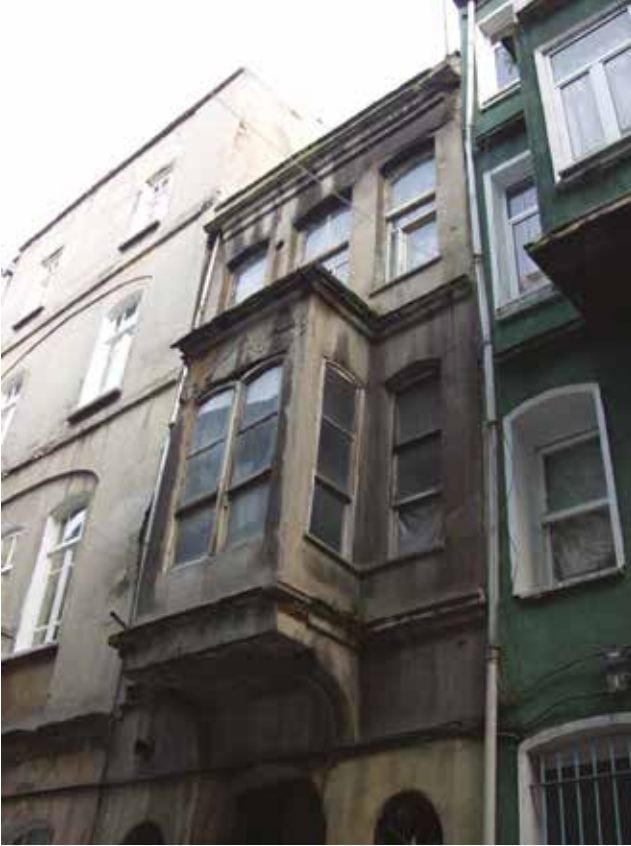
Fotoğraf 8 - 2300 ada 5 numaralı parseldeki yapının restorasyon öncesindeki durumu (Kaynak: www.fenerbalat.org) / The before-restoration situation of the building on the building block 2300 the building lot 5 (Source: www.fenerbalat.org)
