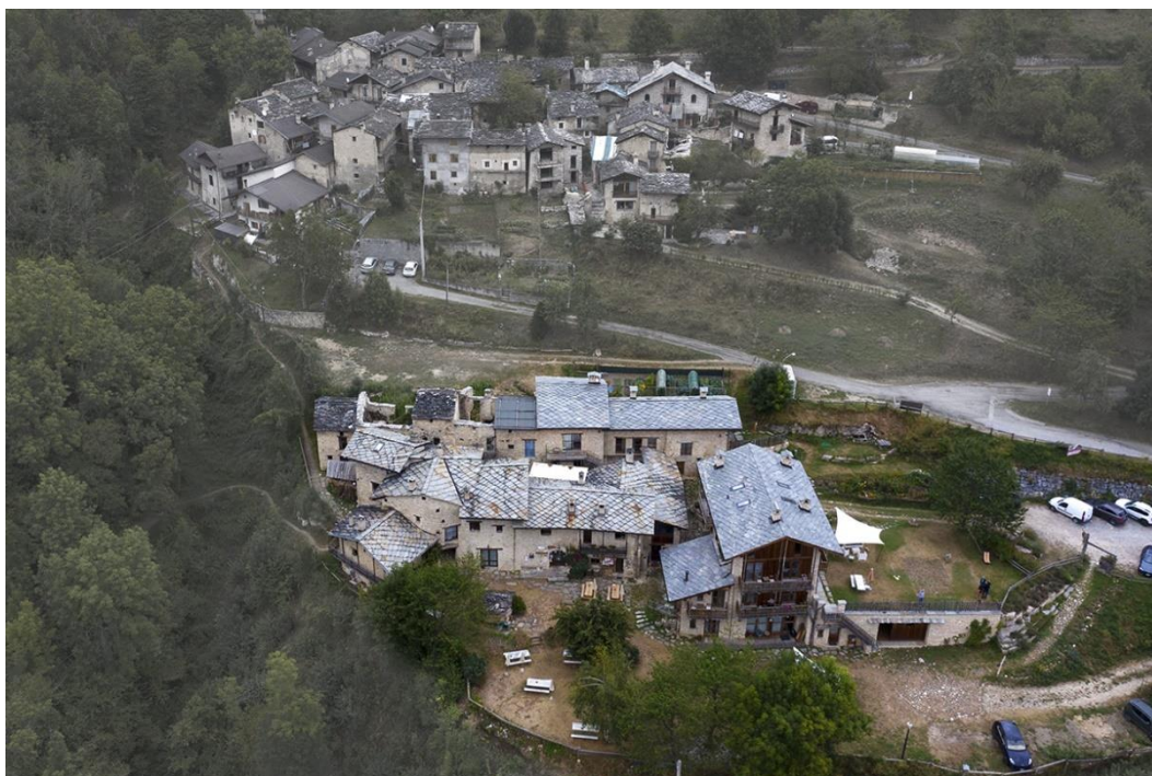
Figura 53 Locanda del Silenzio, veduta aerea
