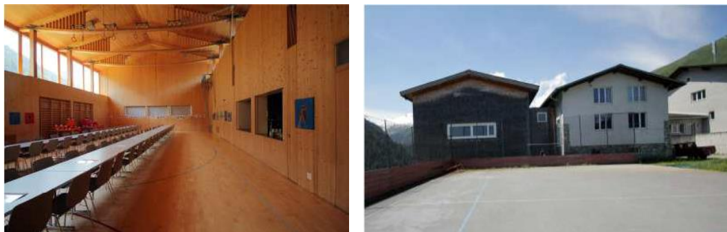
Figura 106 Gion A. Caminada, Vrin, Centro polifunzionale
