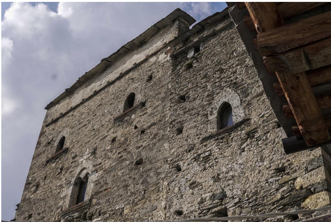
Figura 46 Esempio di costruzione di facciata a vela, borgata Castellaro, Cella Macra
