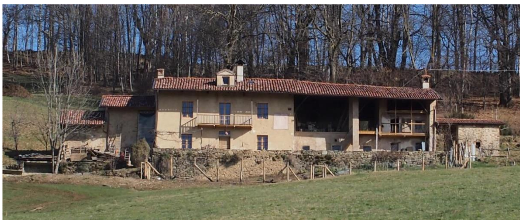
Figura 99 Il corpo architettonico principale
