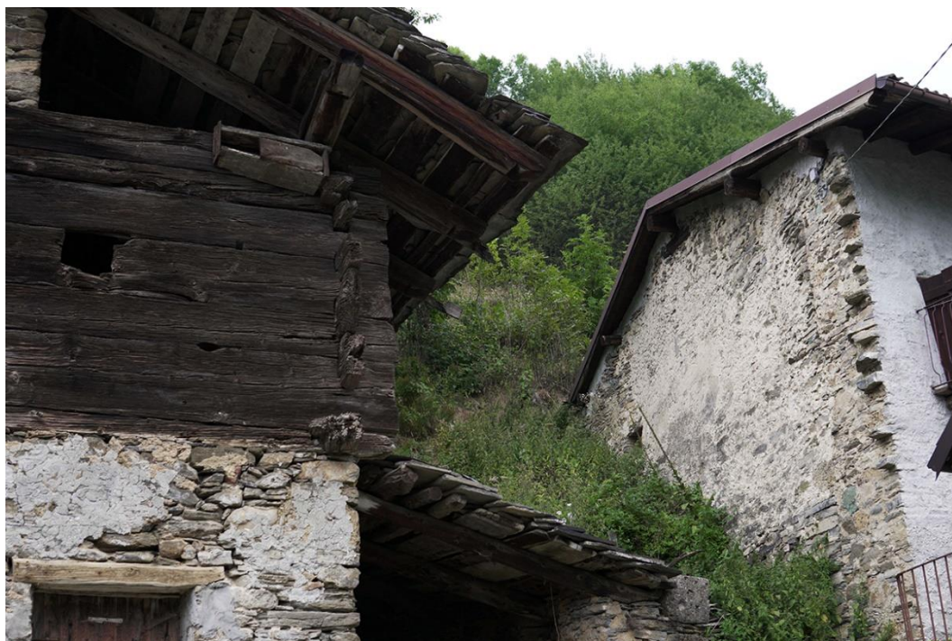
Figura 45 Esempio di struttura in blockbau a Celle Macra, borgata Chiotto
