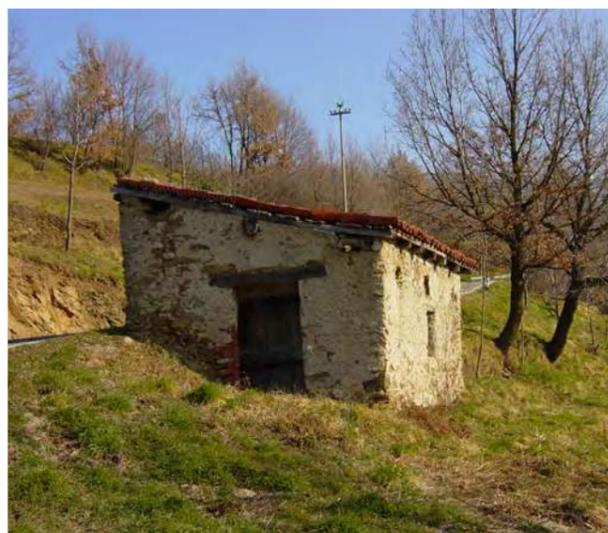
zionali. E' in ogni caso sconsigliabile effettuare, oltre ai già citati ampliamenti, sopraelevazioni e inserire nuovi balconi o ballatoi. L'inserimento di solai con struttura in calcestruzzo armato non è compatibile. Per i collegamenti interni, si consiglia di far uso di scale in legno, in muratura (se le dimensioni lo consentono) o in metallo.
