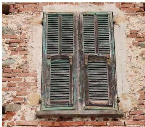
o inferriate. Il legno più utilizzato era il castagno, soprattutto alle quote medie, ma anche il rovere è piuttosto diffuso. E' possibile trovare aperture realizzate con sguinci laterali accentuati, talvolta anche asimmetrici, in funzione dell'orientamento della parete. Sono presenti inoltre aperture ricavate entro pareti in muratura di pietra a vista, contornate da un bordo in intonaco in continuità con quello delle pareti interne.
