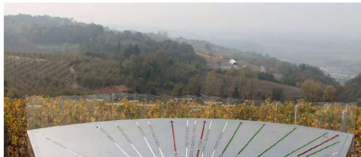
indicazioni (linee direzionali, nomi, distanze) per i punti di interesse del paesaggio. Questi elementi dovranno essere realizzati in acciaio corten, rispettando il disegno e le dimensioni del progetto; le indicazioni saranno incise con taglio laser;
