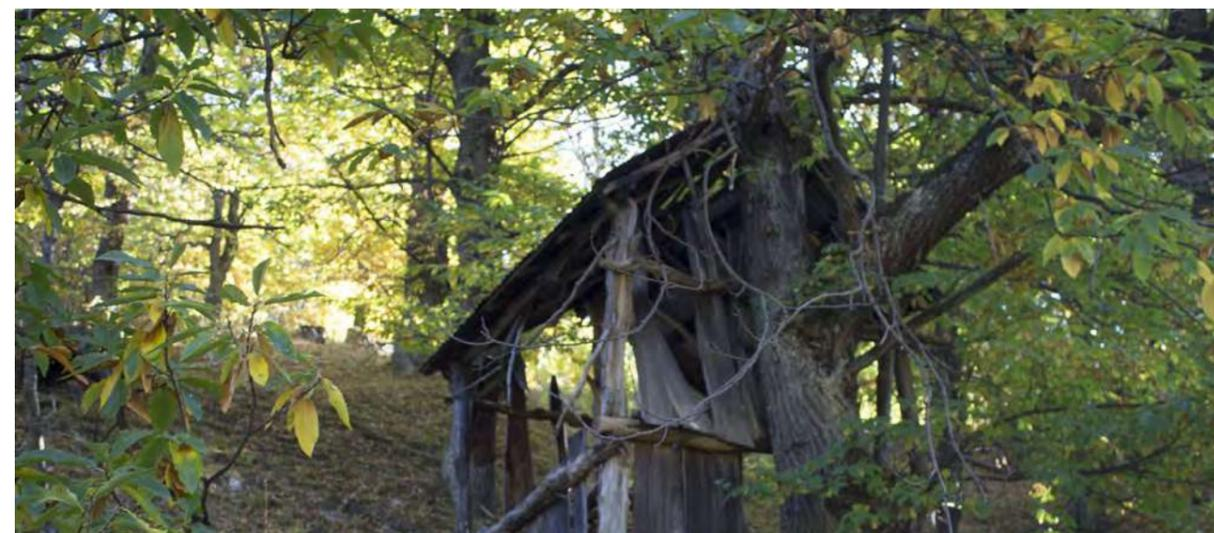
*La paglia è altamente deperibile, infiammabile e difficilmente reperibile al giorno d'oggi, ma le attuali tecnologie permettono di aumentare la durabilità dei materiali e di annullare quasi totalmente la loro incendiabilità, quindi è preferibile sostituire le lamiere con l'originaria tipologia di copertura.*
