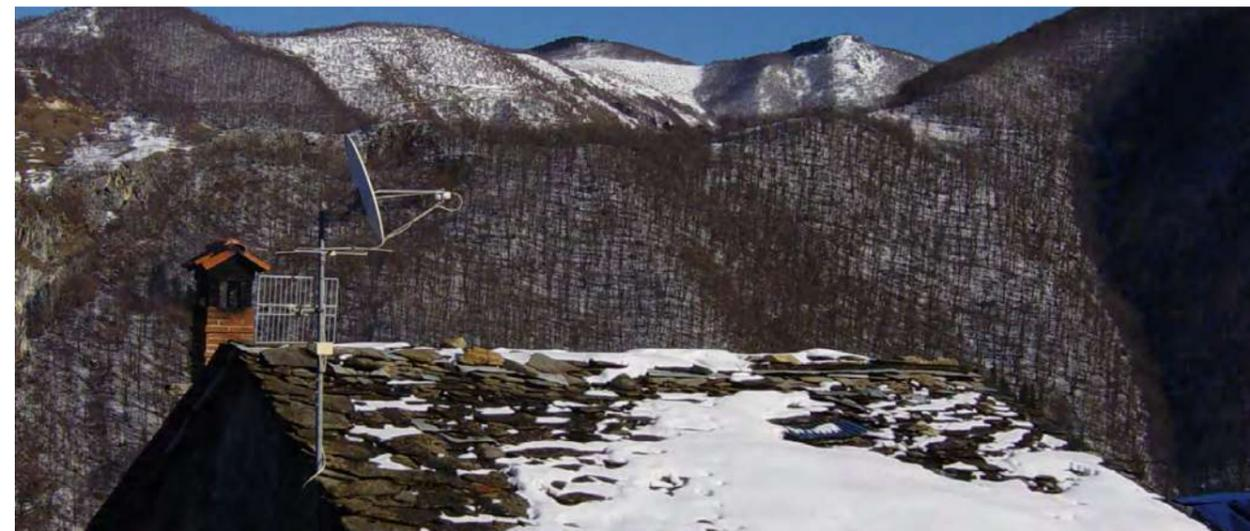
i tetti con manti in pietra e in marsigliesi. Sono comunque stati rilevati casi in cui gli sporti delle falde sono sostenuti da saette in legno incastrate nella muratura. Gran parte dei tetti è in ogni caso privo di canali di gronda e di pluviali.
