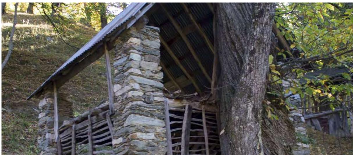
*diabilità, quindi è preferibile sostituire le lamiere con l'originaria tipologia di copertura in pietra o paglia. A livello strutturale, in linea generale, ogni tipo di intervento si attua posteriormente ad un'attenta analisi del manufatto. E' necessario, attraverso un'analisi in loco, valutare lo stato di conservazione del manufatto: una verifica preventiva su quelli che sono i fenomeni di dissesto strutturale, in atto o conclusi, o di degrado del materiale.*
