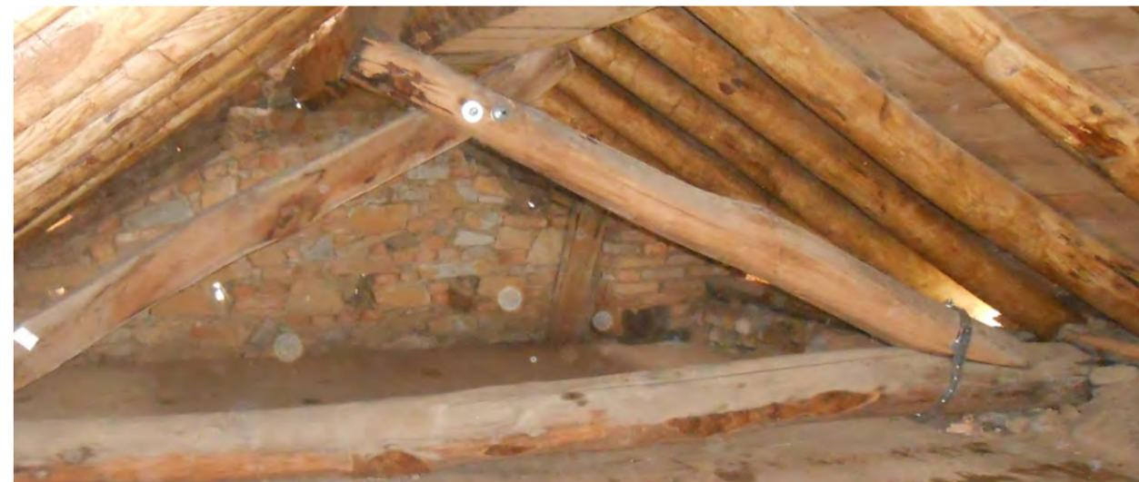
locale, a posa irregolare su tavolato ligneo in castagno e interposizione di una membrana antigoccia impermeabile ma traspirante. E' stata conservata la capriata "arcaica" esistente mentre è stato sostituito il solaio latero-cementizio, estraneo ai caratteri dell'edificio, con un solaio ligneo semplice in legno di castagno.
