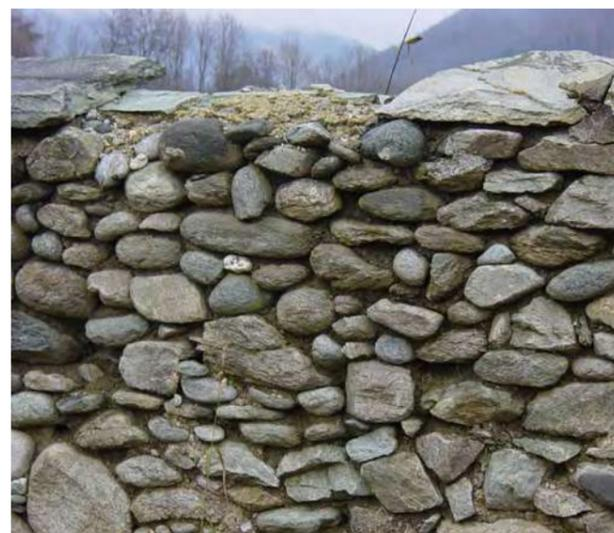
Negli interventi di riparazione e ripristino si consiglia di reimpiegare gli elementi esistenti, recuperati dai crolli e di operare con tecniche murarie analoghe a quelle dell'esistente. Sono da evitare l'impiego di malte cementizie, la realizzazione di doppie pareti con muro in calcestruzzo di cemento armato contro terra rivestito da paramento in pietra, l'impiego di elementi diversi per forma, dimensioni o colore a quelli esistenti.
