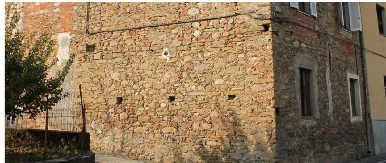
se in alcune zone dell'ambito territoriale numerosi edifici sono realizzati con murature laterizie. Il laterizio era spesso utilizzato in alcuni punti singoli della muratura, come piattabande, archi, stipiti delle aperture e pilastri.
