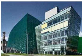
Impianto di Termovalorizzazione, Bolzano
