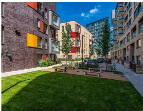
Vista strada pedonale interna
