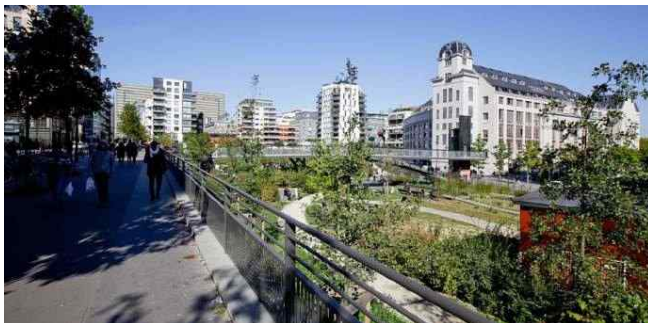
Passerelle des Grands Moulins
