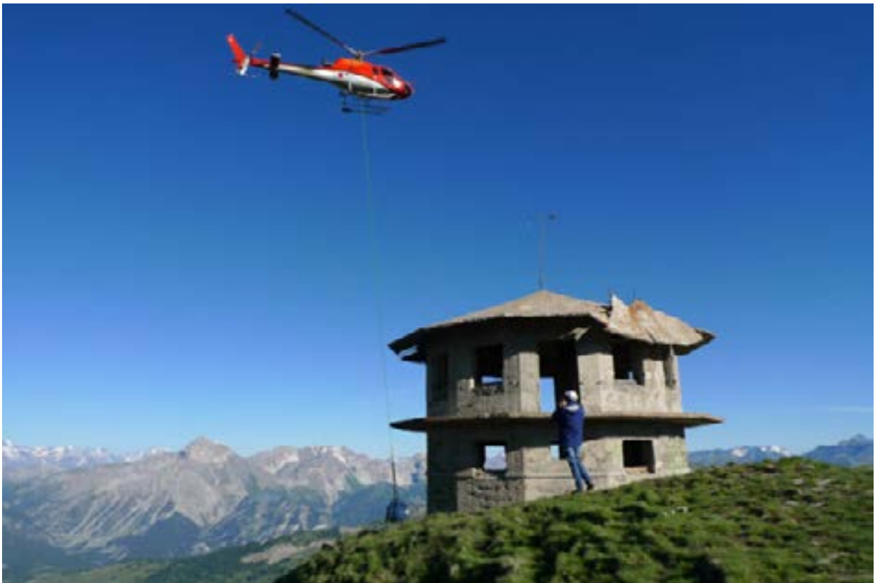
Il Belvedere prima del restauro (2016). Photo © Paolo Luigi Grassi
