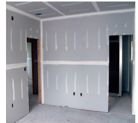
Applicazione del cartongesso da https://www.infobuild.it/approfondimenti/il-cartongesso-caratteristiche-e-impieghi-in-edilizia/
