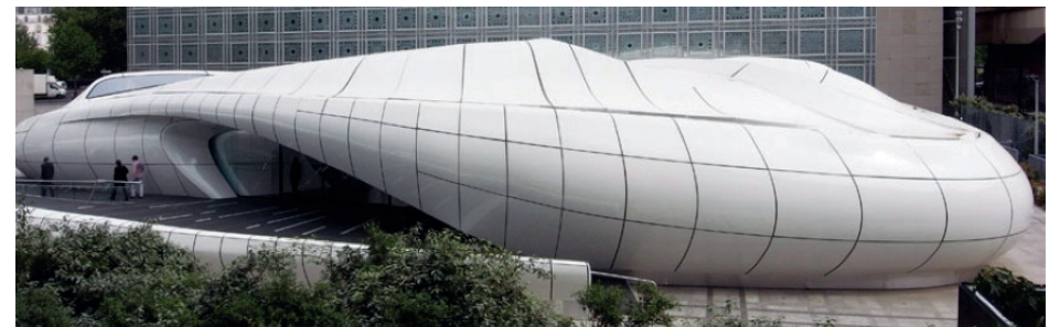
Chanel mobile art pavillon di Zaha Hadid, costituito da una struttura di pannelli rinforzati con fibre di vetro da https://socialdesigntmagazine.com/mag/architettura/exhibit-pavilion-zaha-hadid/
