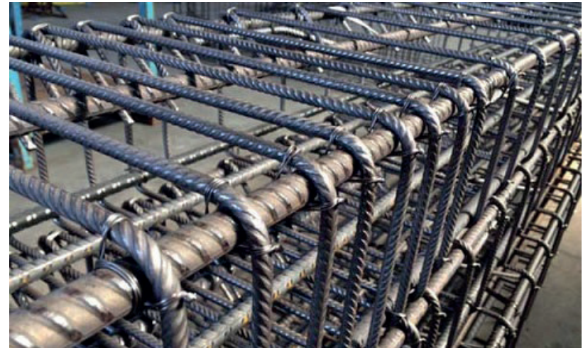
Armatura metallica del calcestruzzo armato da https://www.mecosimmobiliare.it/2020/03/23/armatura-metallica-e-disarmo-delle-casseforme-del-calcestruzzo-armato-cemento-armato/
