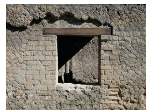
Finestra con architrave in legno, Ercolano (Na) da Campioli A., Lavagna M. (2013), Tecniche e architettura , Città studi
