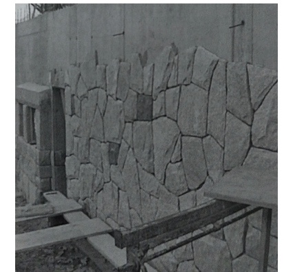
Posa in opera di un rivestimento in pietra su un sottostruttura in c.a. da Campioli A., Lavagna M. (2013), Tecniche e architettura , Città Studi
