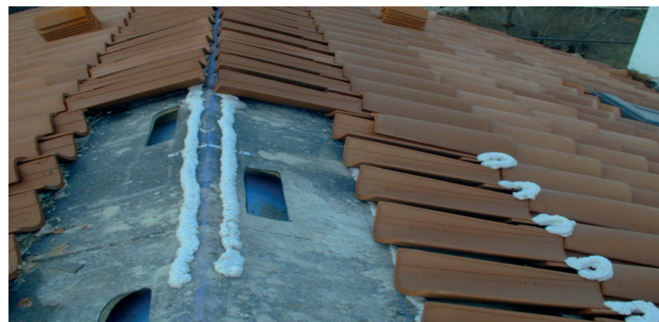
Applicazione schiuma per fissaggio tegole per una copertura inclinata da https://www.steacom.it/isolamento-termico/326-schiuma-poliuretana-professionale-per-pistola-soudal-per-coppie-tegole.html
