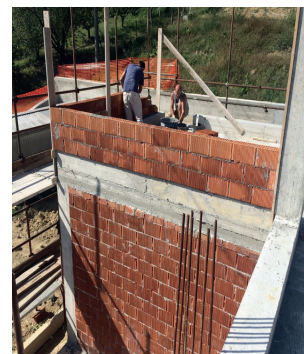
Vista in cantiere da https://www.knaufinsulation.it/applicazioni/pareti-perimetrali
