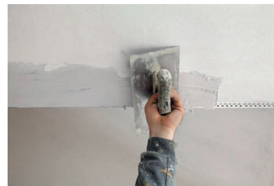
Stesura dell'intonachino da https://www.lavorincasa.it/stendere-lintonaco/
