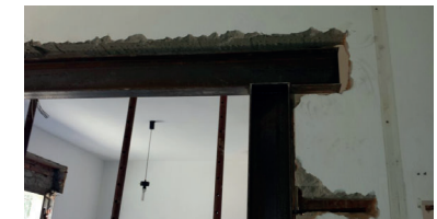
Esempio di una demolizione da https://www.officinadelfabbro.info/wp-content/gallery/travi/IMG-20150429-WA0024.jpg
