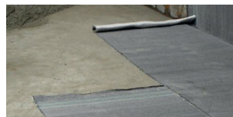
Impermeabilizzazioni con bentonite da https://www.infobuild.it/approfondimenti/impermeabilizzare-con-la-bentonite/
