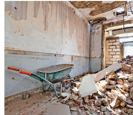
Demolizione da http://www.smeda.it/riciclare-inerti/demolizione-selettiva-smeda/
