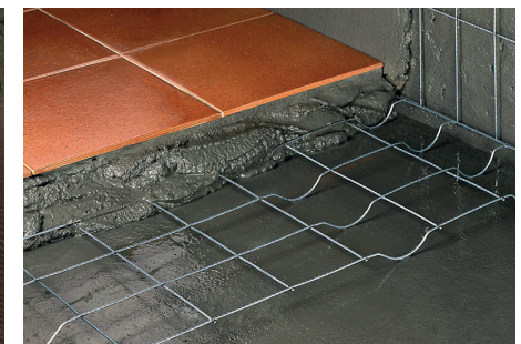
Massetto di sito fondo con rete metallica da https://www.artisticaposa.it/massetti/
