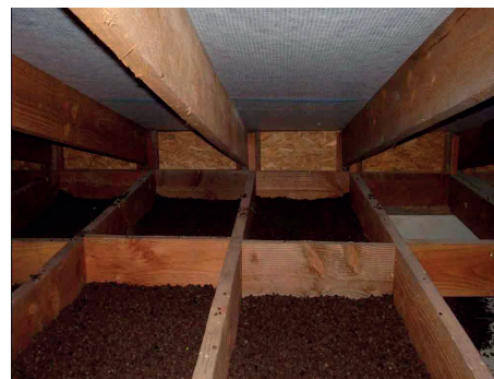
Utilizzo del sughero per garantire isolamento termico e acustico del sottotetto da www.casaenergetica.it/info/tecnologia/materiali/sughero.html
