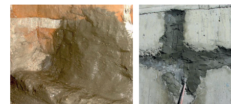
Impermeabilizzazioni con malte cementizie da https://www.diasen.com/sp/it/impermeabilizzanti-malte.3sp https://www.infobuild.it/prodotti/i-plug-malta-impermeabile/
