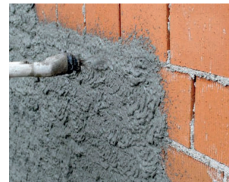
Applicazione di un intonaco composto da leganti idraulici da https://www.infobuild.it/approfondimenti/malte-e-intonaci-caratteristiche-e-impieghi-in-edilizia/
