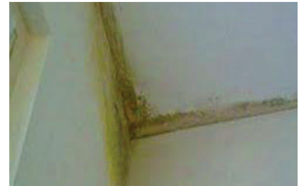
Muffe e batteri visibili a causa di un ponte termico da https://www.bioisotherm.it
