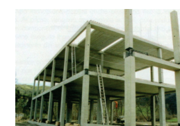
Telaio in cls armato da https://unikore.it/phocadownload/userupload/tiziana.basirico-unikore.it/Arch_Tec_Lez_09_struf%20elevazione.pdf
