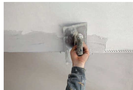
Stesura dell'intonachino da https://www.lavorincasa.it/stendere-lintonaco/
