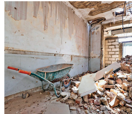
Demolizione da http://www.smeda.it/riciclare-inerti/demolizione-selettiva-smeda/
