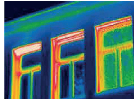
Diminuzione delle capacità di isolamento in corrispondenza degli infissi da https://www.google.com/url?sa=i&url=https%3A%2F%2Fwww.guidafinestra.it
