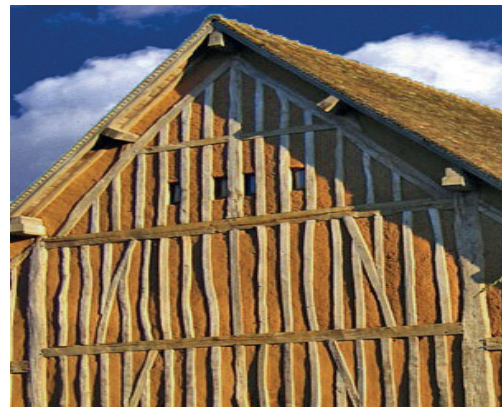
Torchis da http://www.postspritzum.it/redazione/architettura/terra-cruda-la-casa-tradizionale-la-casa-innovativa.php
