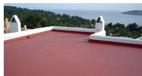
Impermeabilizzazioni con guaina liquida da https://www.albaedile.it/categoria-prodotto/edilizia-e-ferramenta/
