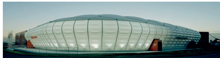
Padiglione Finmeccanica al Farnborough Airshow 2006 di Londra, Studio GRIS - involucro in cuscini pneumatici con layer interno in tessuto poliestere-PVC ed esterno in film trasparente in PVC da https://core.ac.uk/download/pdf/11918179.pdf
