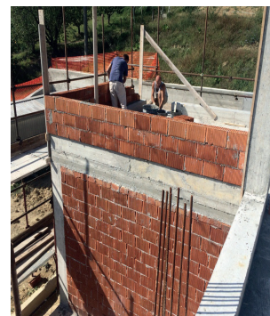
Vista in cantiere da https://www.knaufinsulation.it/applicazioni/pareti-perimetrali
