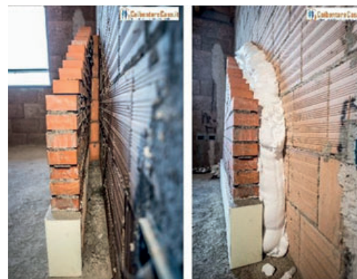
INTERCAPEDINE MURARIA: a sinistra intercapedine muraria pre-esistente non isolata, a destra intercapedine isolata tramite insufflaggio da https://www.guidaxcasa.it/intercapedine-nelle-abitazioni-la-sua-coibentazione-un-tesoro-da-non-sottovalutare/
