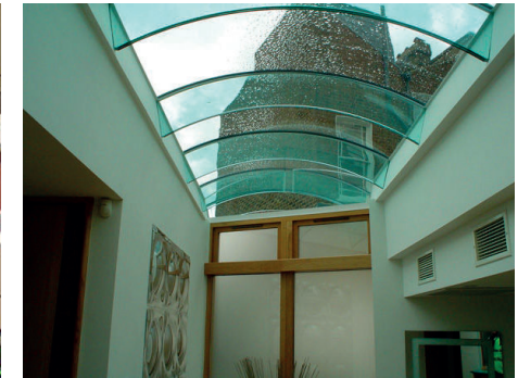
Copertura in vetro con struttura in vetro da https://www.archiexpo.it/prod/glazing-innovations/product-61869-391445.html
