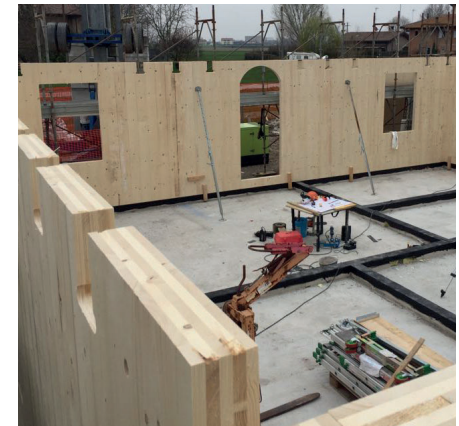
Pareti realizzate in legno xlam da https://www.casaattiva.com/wp-content/uploads/2018/03/IMG-20180328-WA0002.jpg
