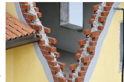
Isolamento in intercapedine da https://www.soloecologia.it/02112016/panoramica-dei-variti-pi-insufflaggio-per-la-coibentazione-delle-case/9060
