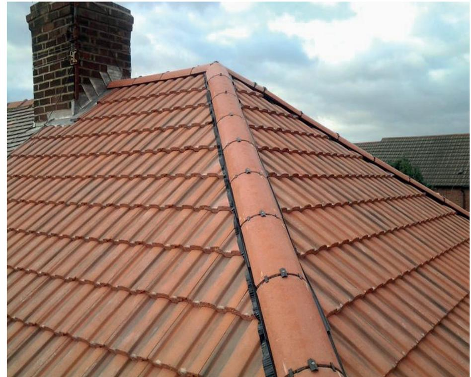
Esempio di colmo da <https://www.casapratice.org/muri-tetto/tetti-e-solai/colmo-tetto.asp>
