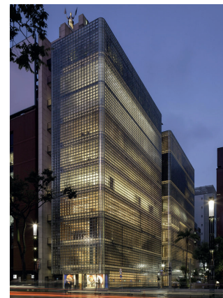
Esempio di utilizzo esterno del vetrocemento, Maison Hermes di Tokyo da https://www.flickr.com/photos/64210496@N02/49440924737
