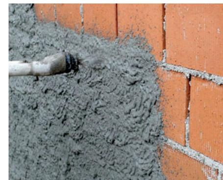
Applicazione di un intonaco composto da leganti idraulici
