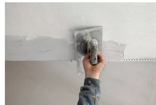
Stesura dell'intonachino da https://www.lavorincasa.it/stendere-lintonaco/
