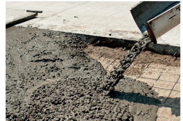
Getto in opera di calcestruzzo da http://www.infoacciaio.com/glossario/calcestruzzo/
