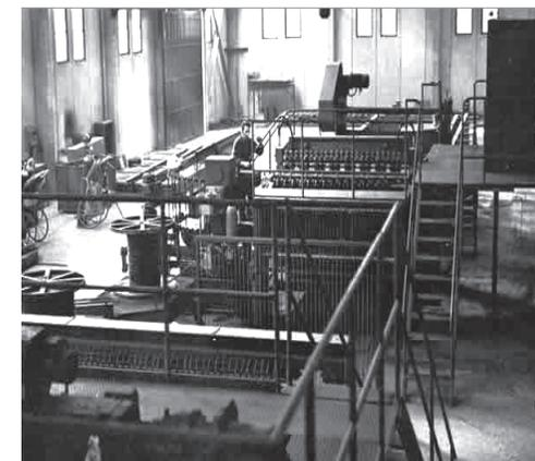
Impianto di produzione reti elettrosaldate
