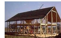
Struttura a telaio in legno da [https://unikore.it/phocadownload/userupload/tiziana.basirico-unikore.it/Arch\\_Tec\\_Lez\\_09\\_struf%20elevazione.pdf](https://unikore.it/phocadownload/userupload/tiziana.basirico-unikore.it/Arch_Tec_Lez_09_struf%20elevazione.pdf)
