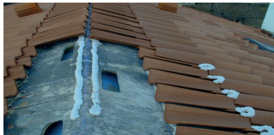
Applicazione schiuma per fissaggio tegole per una copertura inclinata
