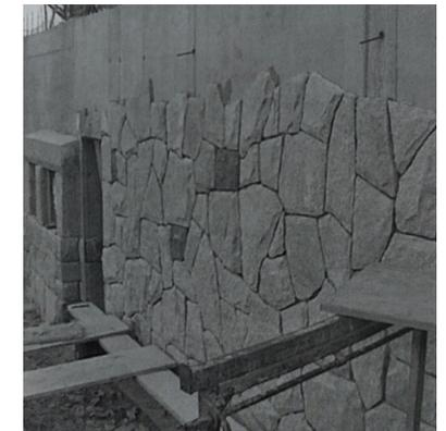
Posa in opera di un rivestimento in pietra su un sottostruttura in c.a.
