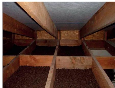
Utilizzo del sughero per garantire isolamento termico e acustico del sottotetto
