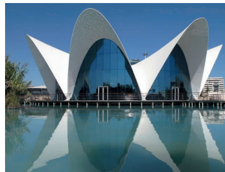
Felix Candela, l'oceanografic, Valencia, 1994 da http://bim.acca.it/strutture-curve-in-cemento
