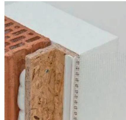
Controtelaio a "L" in legno (OSB) posato sulla muratura. Dall'immagine si nota la schiuma poliuretanica espansa insufflata nello spazio tra muratura e controtelaio, che poi verrà protetta con un barriera al vapore interna
