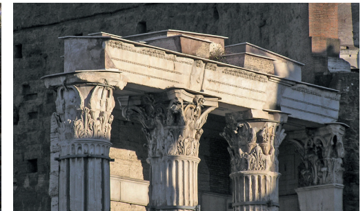
Architrave ionico con fasce sulle colonne della peristasi del tempio di Marte Ultore nel Foro di Augusto, a Roma da https://it.wikipedia.org/wiki/Architrave#/media/File:ItaliaRomaForoAugusto-TempioArchitrave.jpg
