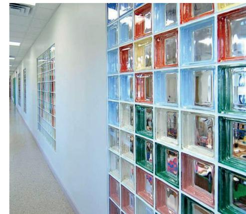
Esempio di utilizzo interno del vetrocemento da [https://www.designmag.it/foto/vetrocemento\\_6279.html](https://www.designmag.it/foto/vetrocemento_6279.html)
