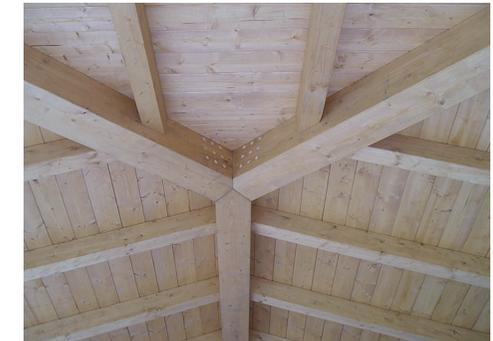
Particolare di copertura in legno lamellare da <https://www.losalegnami.com/tetti-legno/tetti-in-lamellare/>
