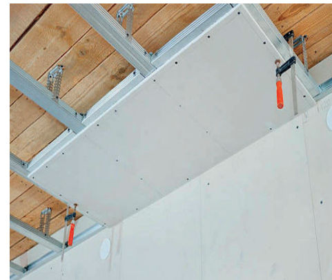
Applicazione del cartongesso da https://www.ilportaledellimbianchino.com/2318/guida-al-cartongesso-descrizione-tipologie-utilizzo-posa-costi/
