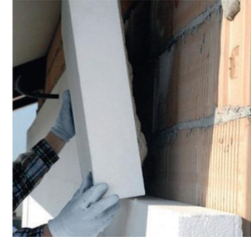
Posa di pannelli in EPS per la realizzazione di un cappotto termico
