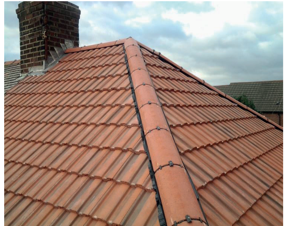
Esempio di colmo da https://www.casapratice.org/muri-tetto/tetti-e-solai/colmo-tetto.asp
