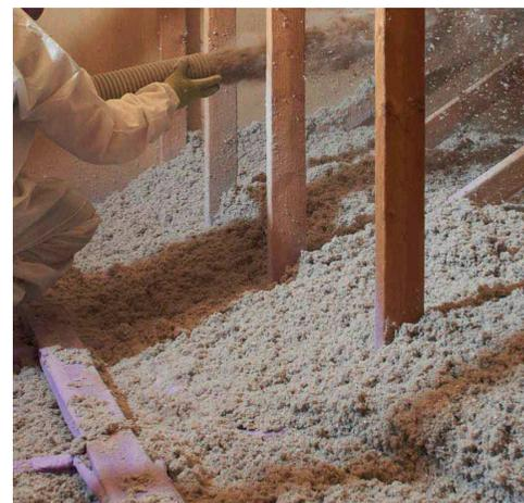
Isolamento sottotetto con fibra di cellulosa
