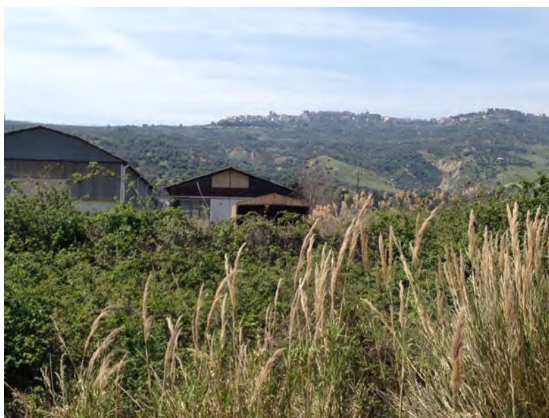
Figura 3 | Capannoni dismessi nella zona industriale di Ferrandina, Val Basento (MT). Fonte: rilievo diretto.
