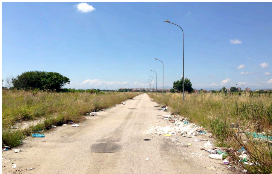
Figura 4 | Area Pip della Marchesa, Acerra. Stato dei luoghi.
