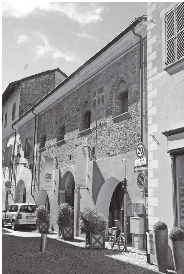
Fig. 2 – Savigliano, palazzo comunale, fronte verso la platea dell'espansione occidentale del borgo, così come ripristinato a seguito dei restauri integrativi degli anni Ottanta del Novecento (foto dell'autore).
