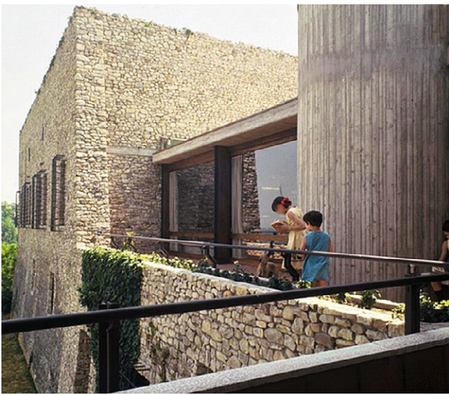
fig. 3 – Connessione tra antica e nuova struttura nel recupero del castello medievale sul colle Mucciarella (fotografia Studio Canali Associati).
