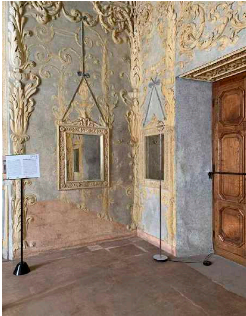
Figg. 8-9. Dettaglio del pavimento in cocciopesto e della decorazione a graffito, Gabinetto dei Fiori Indorato, Castello del Valentino, Torino [fotografia dell'autore, 2021].
