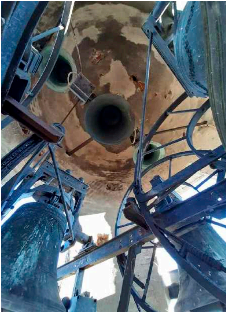
Fig. 15. Il concerto di campane elettrificate [fotografia degli autori, 2020].
