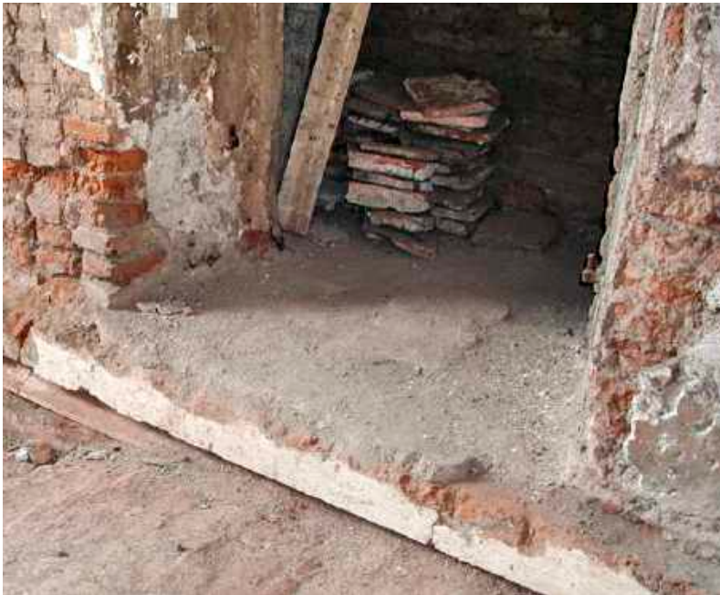
Fig. 7. Pavimentazione del piano terreno negli appartamenti bassi, guardaroba, Reggia di Venaria Reale [fotografia di Mauro Volpiano, 2001].
