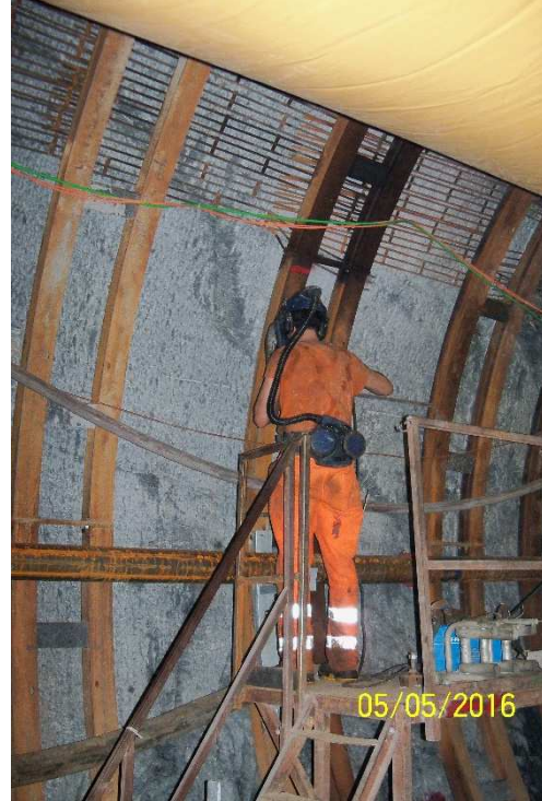
Figure 5. Casque à visière Sundstrom Safety(R) SR 580 et unité de ventilation Sundstrom Safety(R) SR 500
