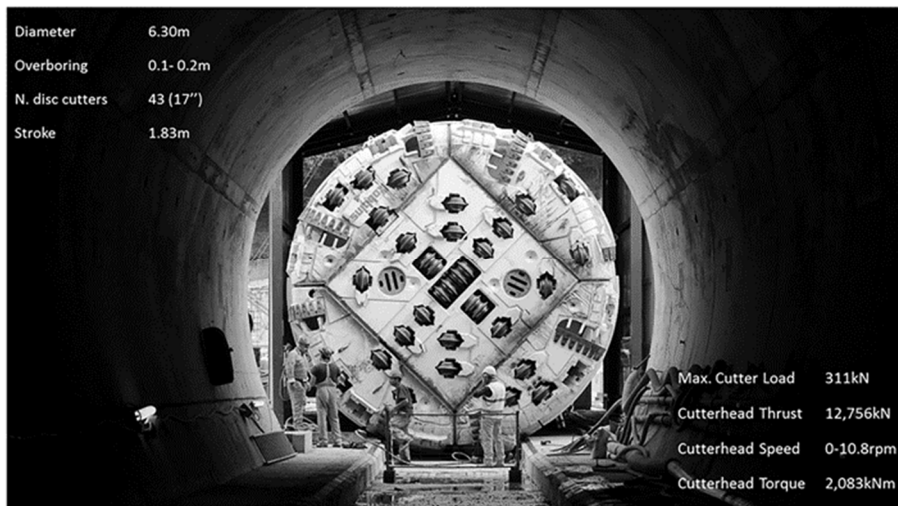
Figure 3. Tunnelier dans la galerie de reconnaissance « La Maddalena ».
