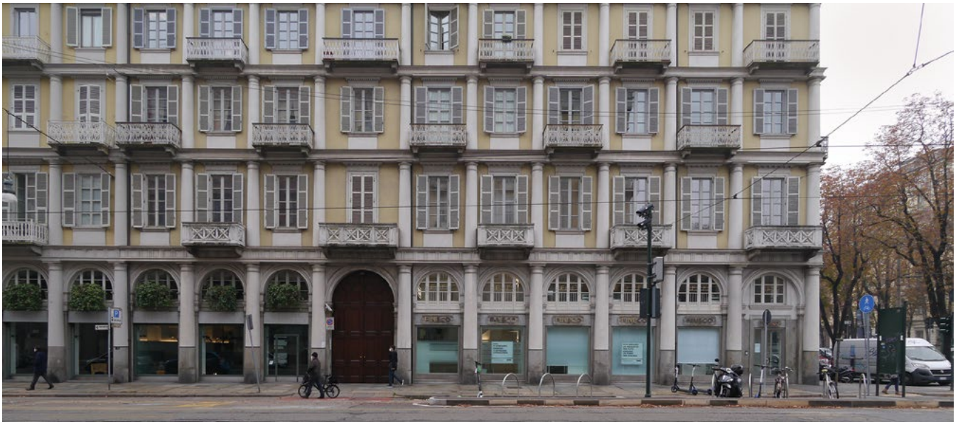
Figura 16. Casa Ponzio-Vaglia (Alessandro Antonelli, dal 1853) o “casa delle Colonne” (foto di Gianfranco Cavaglià, novembre 2020). Già esempio di edificio con schermatura intercambiabile tra estate (persiane) ed inverno (secondo infisso vetrato al posto delle persiane): oggi gli elementi intercambiabili, a seguito di manutenzione straordinaria, non sono più presenti. Comprensibile la scelta, con il rammarico dell’eliminazione di un elemento costruttivo intercambiabile, che documentava la possibilità di migliorare le condizioni ambientali interne al variare delle stagioni, senza impiego di energia (Franco Rosso aveva anticipato già nel 1982, con il titolo provocatorio di una rubrica su «Nuovasocietà», Uno sfregio alla volta, i problemi di tutela e di restauro).
