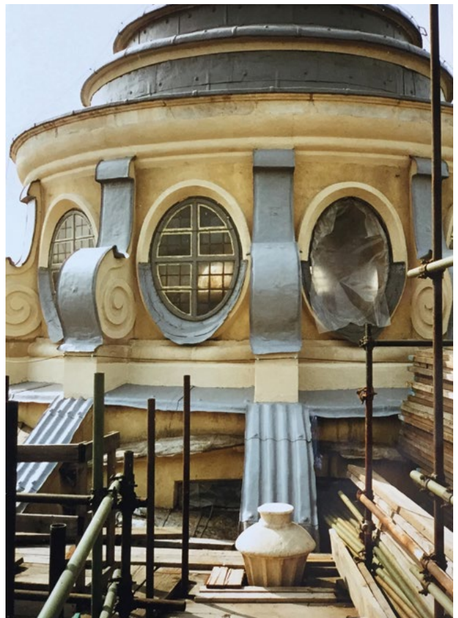
Figura 8. La lanterna della cappella della Sindone, circa 1995. Sopralluogo e fotografia durante i lavori di manutenzione: una opportunità per raggiungere luoghi altrimenti non praticabili e impostare il rilievo di parti complesse e comprendere le opere di completamento. © Fondo Franco Rosso, Archivio di Stato di Torino.
