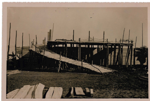
Fig. 5. Foto di cantiere del Calvario (1934).
