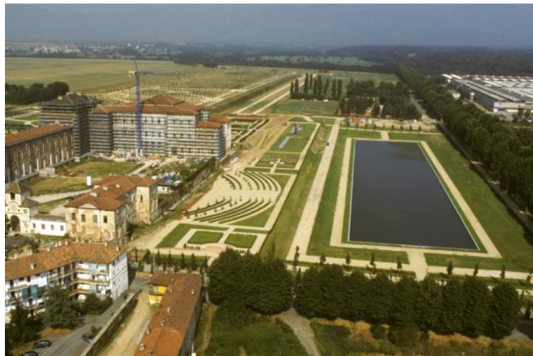
Venaria Reale, giardini della Reggia. Fotografia aerea del 2003 circa (da Francesco Pernice, Alberto Vanelli (a cura di), La Venaria Reale. Lavori a corte: i progetti, i cantieri, le destinazioni , vol. II, Ages, Torino 2006, p. 15).
