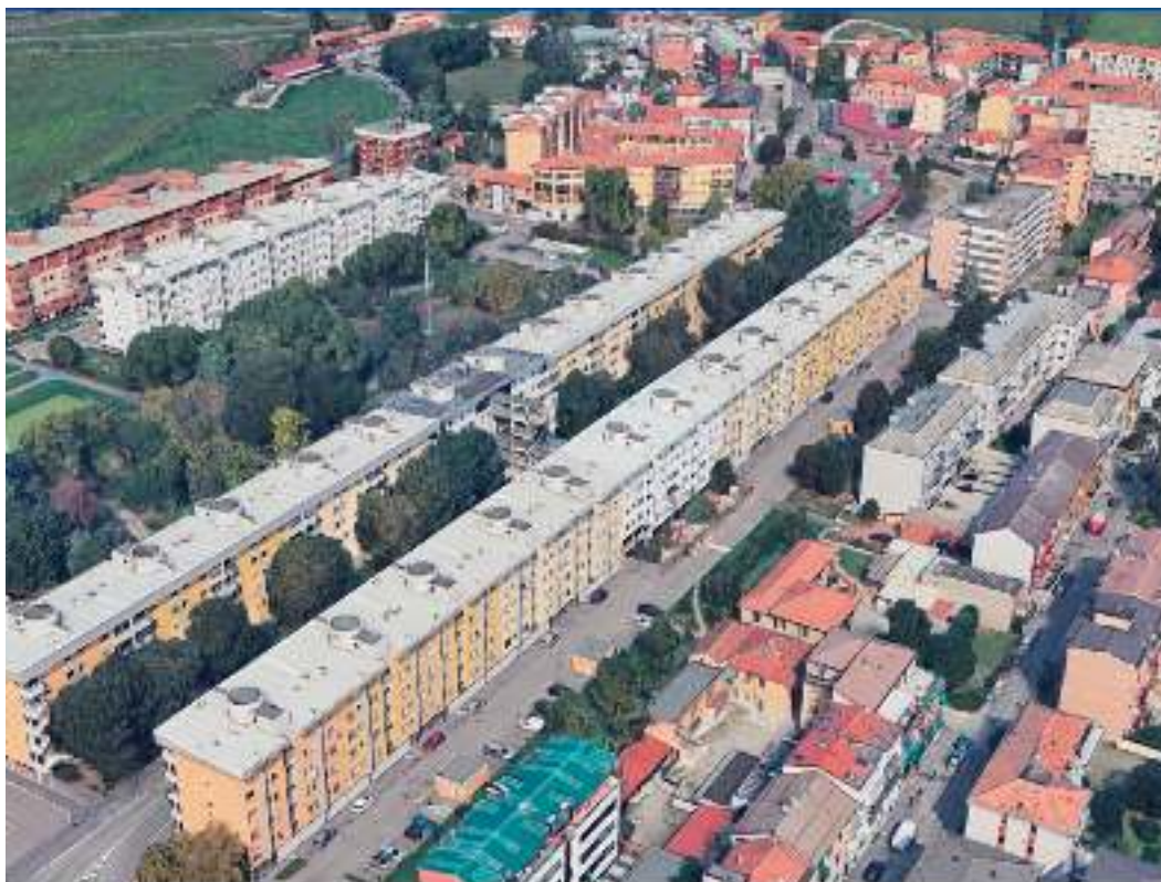
Figura 1 | Vista del quartiere Ponte Lambro, al margine est di Milano. Fonte: www.blog.urbanfile.org Milano Ponte Lambro – La periferia dimenticata
