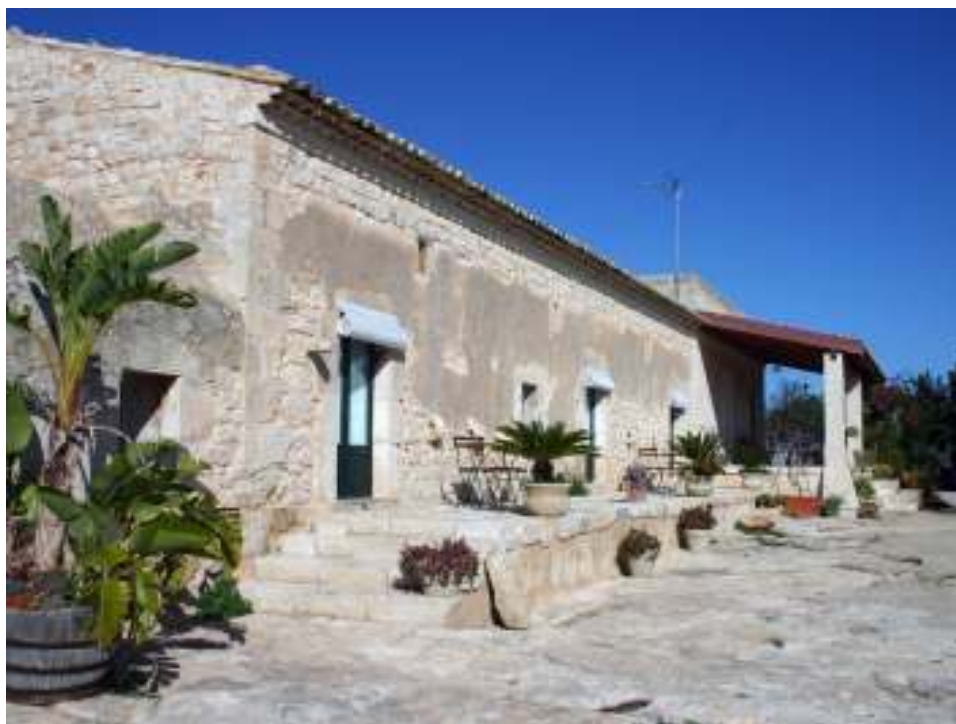
Figura 8 | Edificio rurale recuperato nell'hinterland ibleo. Fonte: foto dell'autore.
