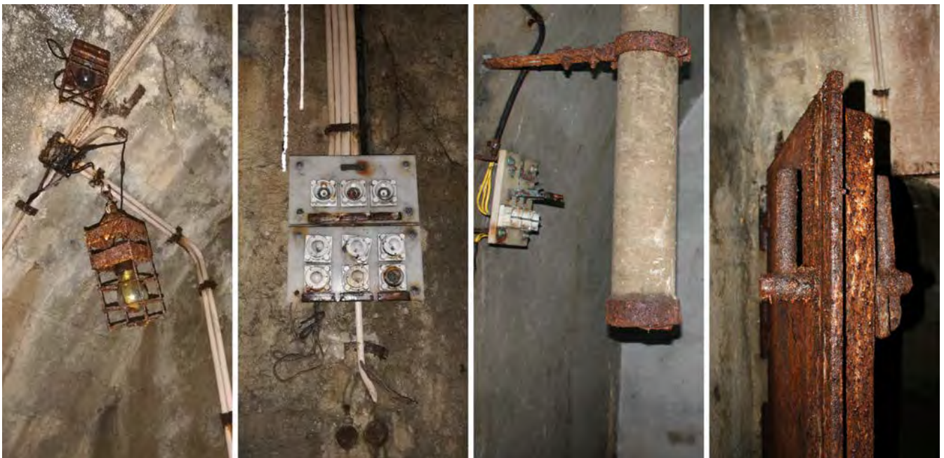
5: Alcuni dettagli dei dispositivi che è ancora possibile apprezzare all'interno del rifugio. Da sinistra: gabbia metallica contenente una lampadina, quadro elettrico, tubatura di areazione, porta blindata (foto degli autori).
