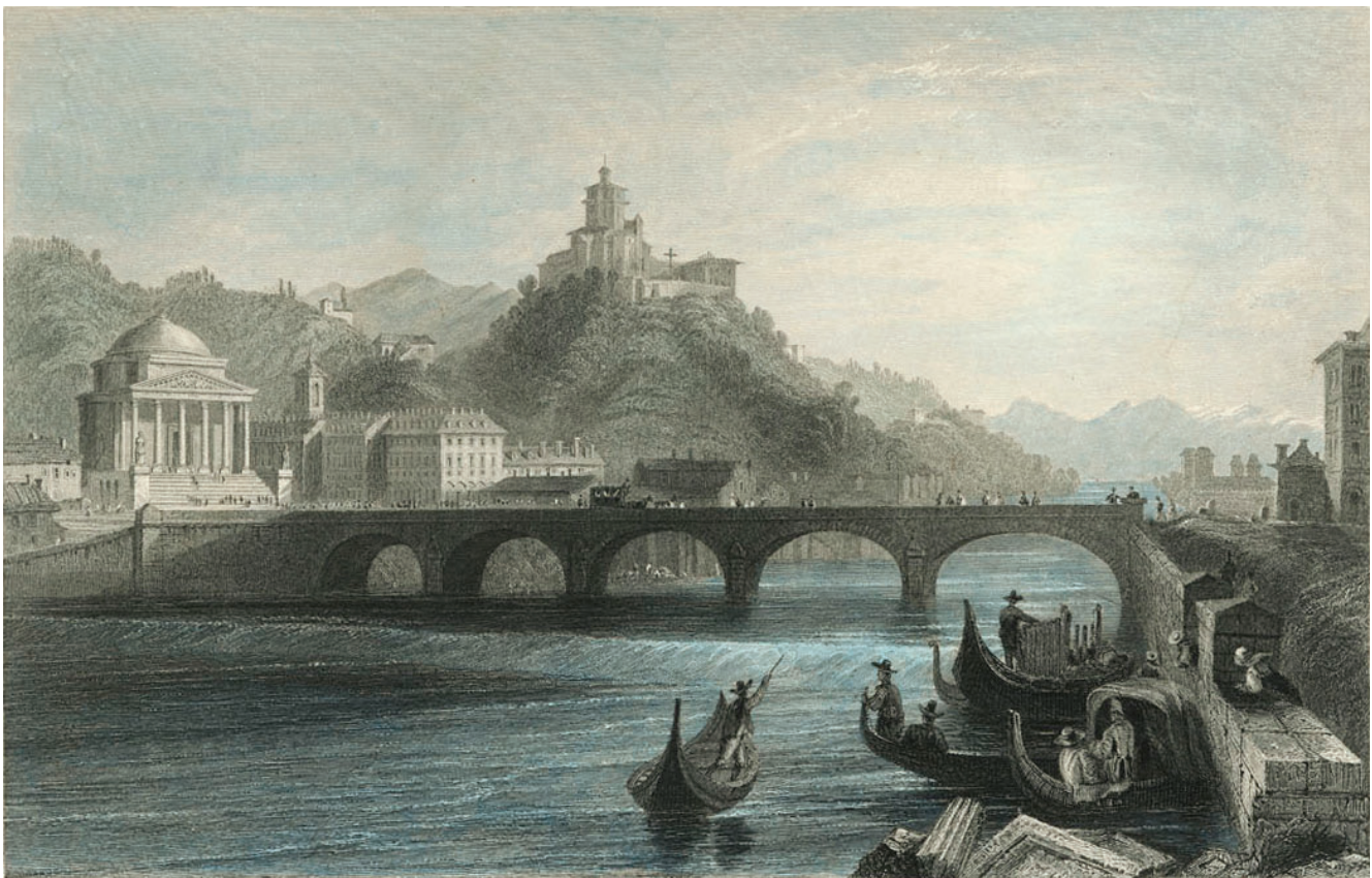
fig. 7 - WILLIAM HENRY BARTLETT, The Bridge of the Po. (Turin) , incisione in acciaio di Robert Wallis. Veduta prospettica del ponte in pietra sul Po, della piazza e chiesa della Gran Madre di Dio, del Monte dei Cappuccini (ASCT, Nuove Acquisizioni ico 289).
