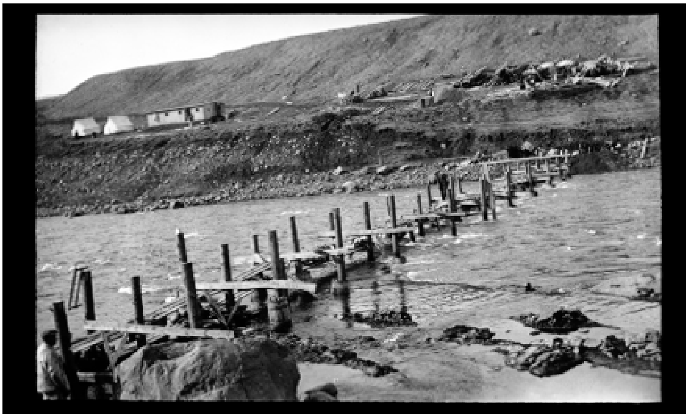
Fig. 35a – The bridge in construction, 1908. DTU Historie- og samlingsdatabase.
