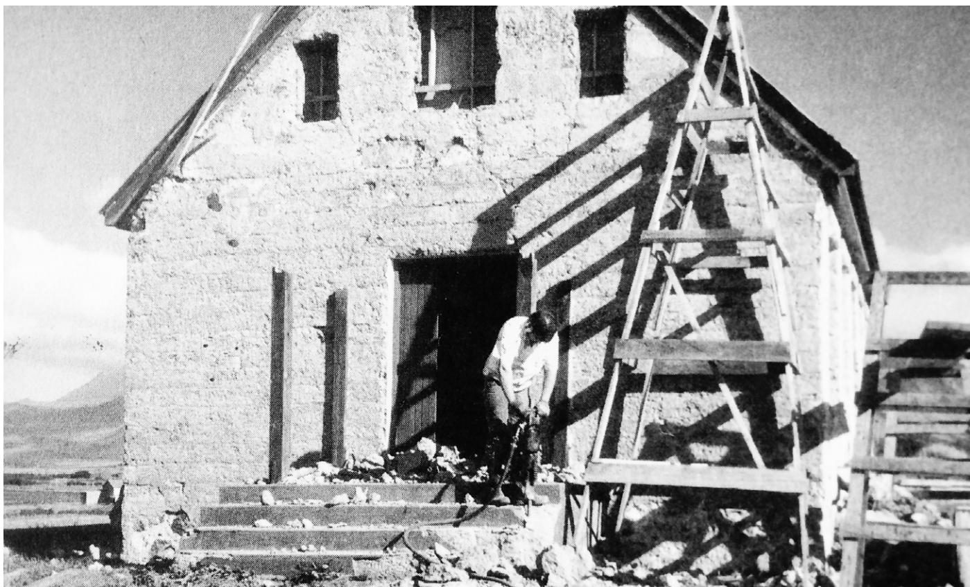
Fig. 17a – House in Garðar, Akranes. Lýður Björnsson, Steypa lögð og steinsmíð rís , 61.
