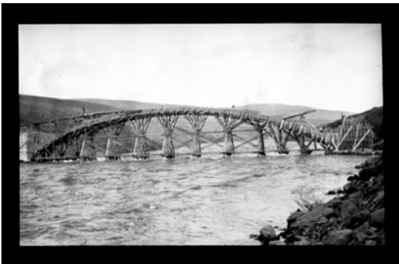
Fig. 35b – The bridge in construction, 1908. DTU Historie- og samlingsdatabase.
