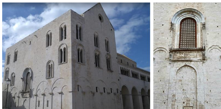
Fig. 8. Vista della parete absidale della basilica di San Nicola e in particolare della monofora vista da mare.
