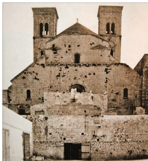
Fig. 3. Fotografia della facciata principale della cattedrale di San Corrado prima dei restauri del XX secolo.
