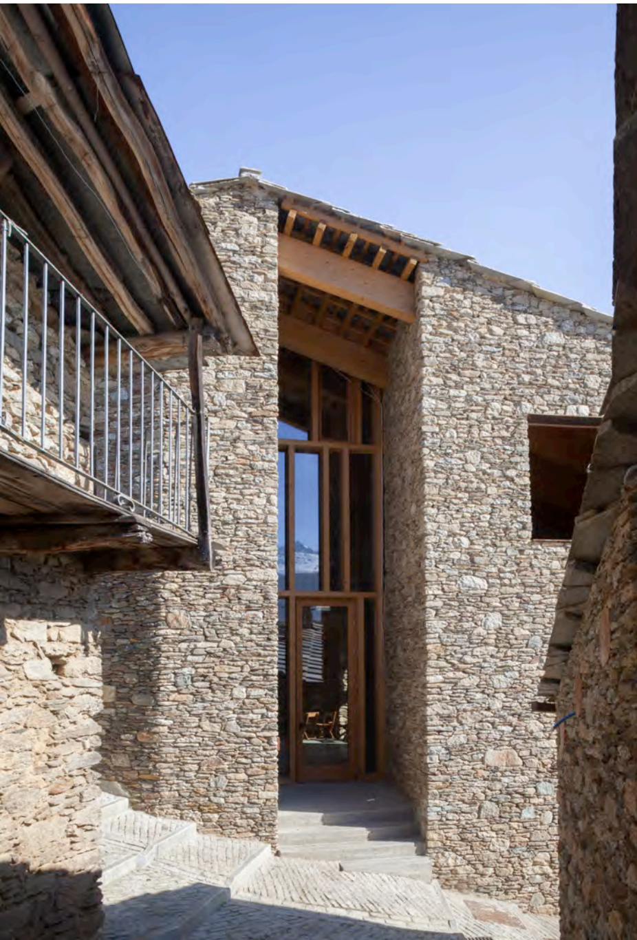
Vista dell'ingresso ovest del Centro Culturale Lou Pourtoun
