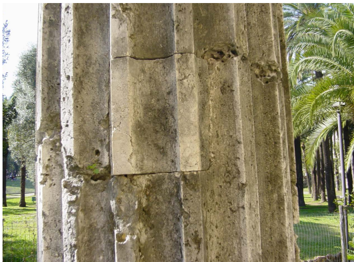
Figura 25, Rudere di ninfeo a villa Torlonia, particolare del tassello di “falso restauro” in una delle colonne, 2003 (foto dell'autore).
