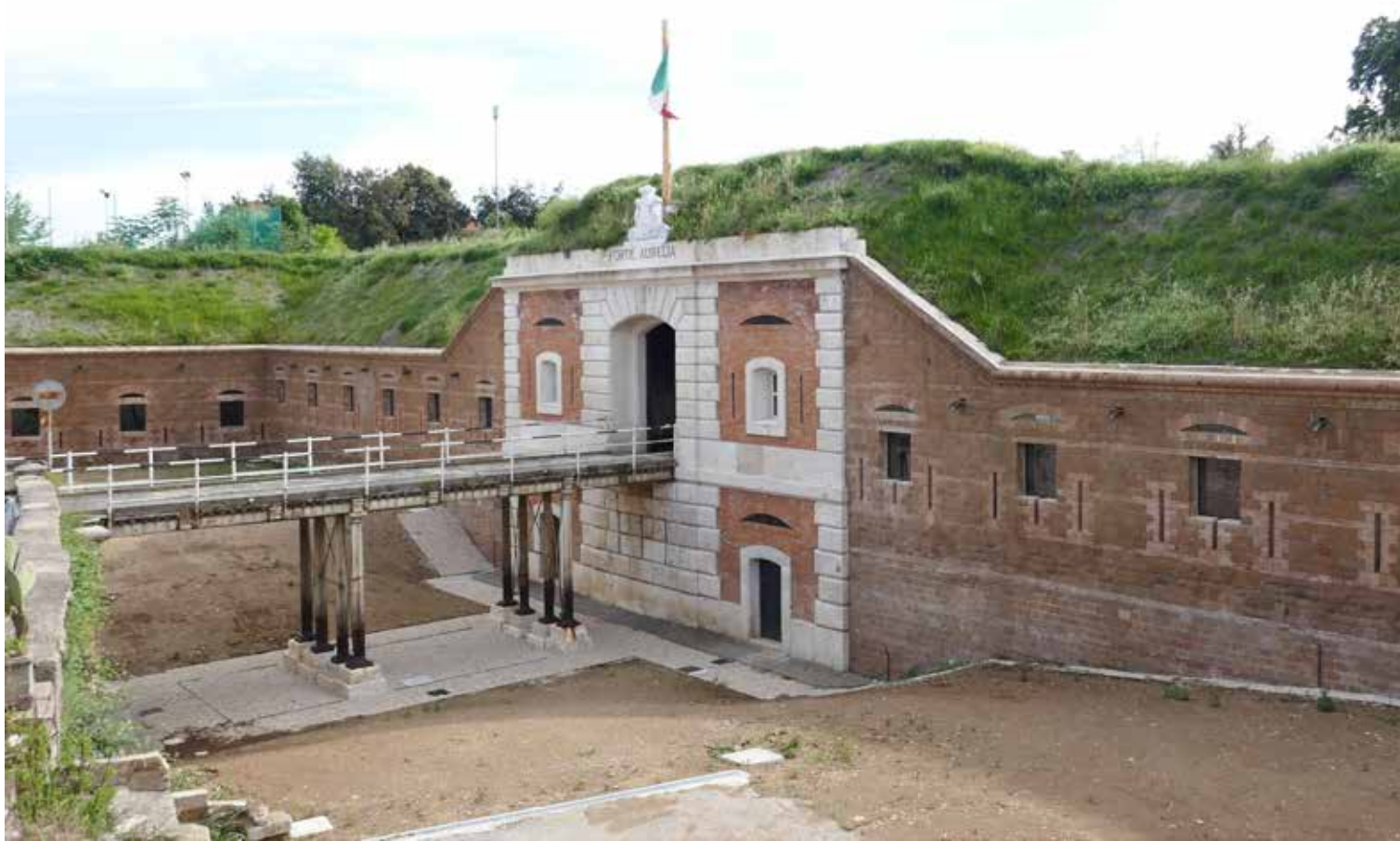
Forte Aurelia, il fronte di gola dopo lo scavo del fossato e il restauro del prospetto (F. Meneghelli, 2019).
