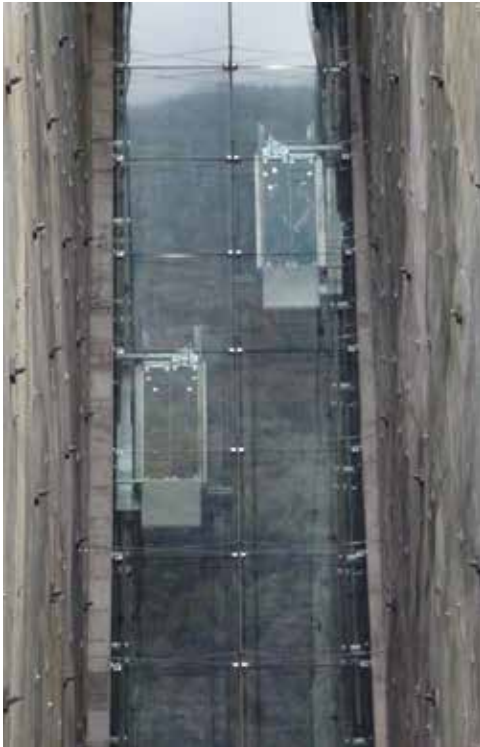
Forte di Exilles (TO), Dettaglio parete nuovi ascensori e controcampo sulla valle (Tetrastudio, 2011).
