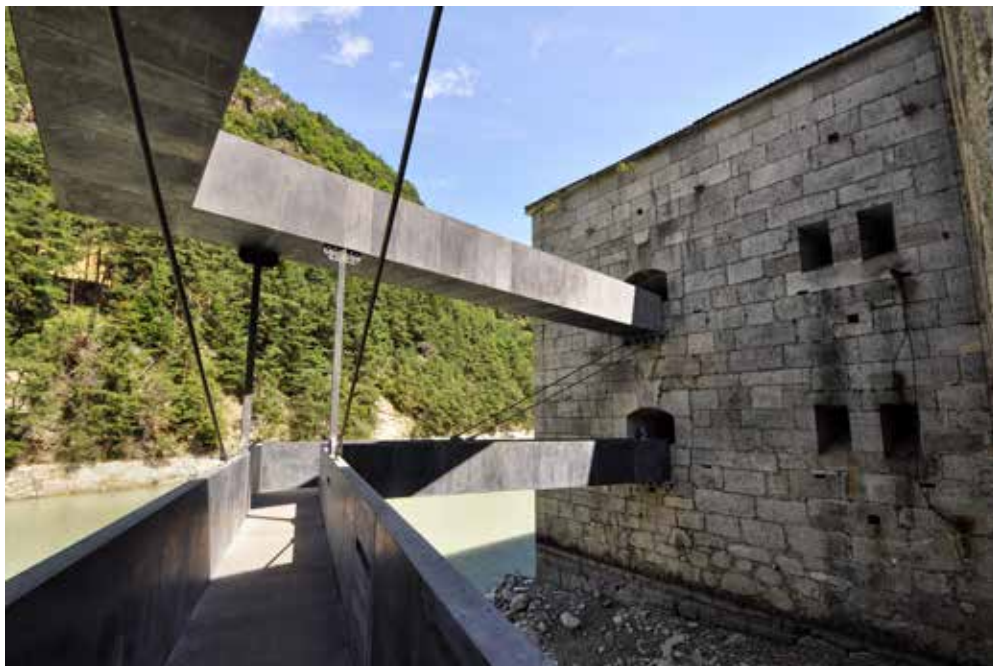
Fortezza (BZ), Forte austro-ungarico di Fortezza (R.Nadalin).
