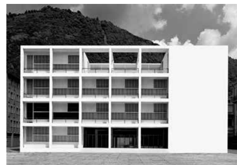
Como, Casa del Fascio (G. Terragni, 1936), sede del Comando Provinciale della Guardia di Finanza.
