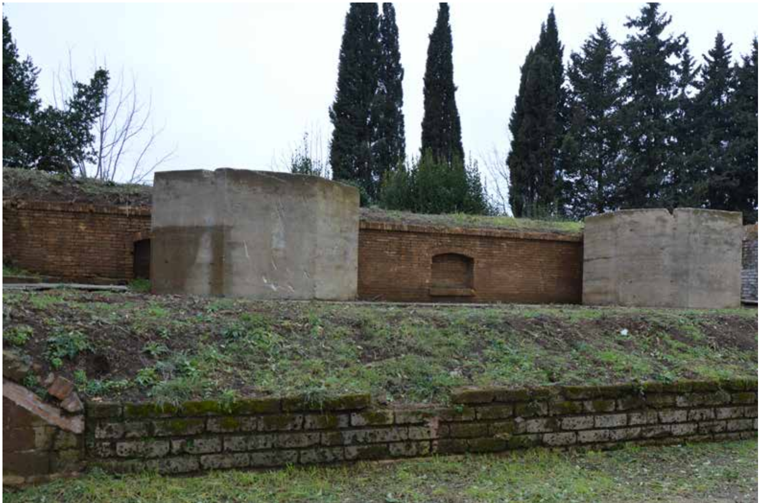
Forte Aurelia, impiego di differenti materiali nelle strutture di supporto alle artiglierie al piano del ramparo, dal lapideo al laterizio, fino al più recente calcestruzzo (D. R. Fiorino, 2019).
