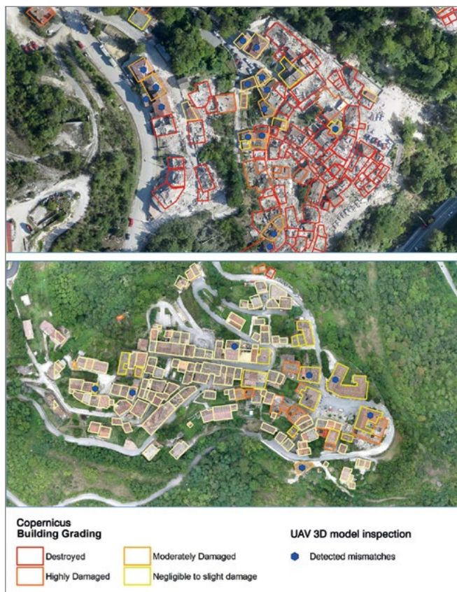
Figura 13. Estratti delle ortofoto (non in scala) di Accumoli (alto) e Pescara del Tronto (basso). Sono riportate le classi di danno determinate dal servizio EMS di Copernicus e le integrazioni date dal contributo UAVs (esagoni blu).
