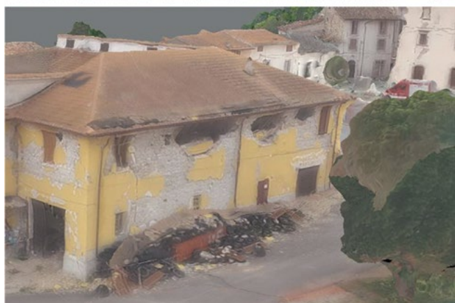
Figura 15. Accumoli, BDA di un edificio campione. In alto a sinistra la grading map di Copernicus, a destra la stessa mappa sovrapposta all'ortofoto da UAVs. In basso una vista dei danni ai fronti dell'edificio individuati sul modello 3D derivato da UAVs.
