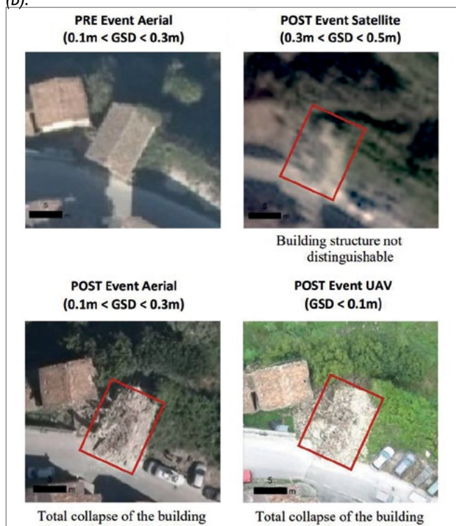
Figura 7. Scala di danno agli edifici proposta da IWG-SEM: esempio di linee guida interpretative per la classe "Destroyed".
