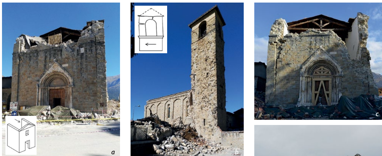
Figura 5. Evoluzione dei crolli durante la sequenza sismica. (a) La chiesa di Sant'Agostino dopo la prima scossa sismica del 24 agosto 2016. (b) Il crollo dell'arco "Carbonara" e il danno sulle strutture murarie del campanile (le immagini riportano anche gli schemi dei meccanismi di danno in relazione agli elementi architettonici della chiesa, secondo la Direttiva del Presidente del Consiglio dei Ministri 9 febbraio 2011, Valutazione e riduzione del rischio sismico del patrimonio culturale con riferimento alle Norme tecniche per le costruzioni di cui al D.M. 14/01/2011. Pubblicata nella G.U. n. 47 del 26/02/2011, suppl. ord. n. 54, 2011) (c) Progressivo collasso della facciata dopo il sisma del 30 ottobre 2016. (d) Ultimo collasso dopo il terremoto del 18 gennaio 2017.
