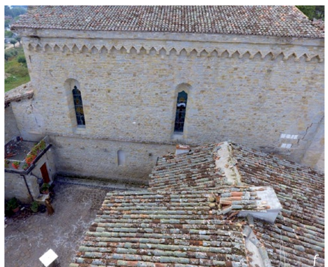
Figura 6. Una sequenza di immagini da UAV acquisite dal gruppo SAPR dei Vigili del Fuoco dopo il 24 agosto 2016. (a) muratura danneggiata in prossimità dell'intervento di inserimento del rosone in facciata, caratterizzata da una elevata vulnerabilità; (b-c) effetto del ribaltamento della facciata, visto da entrambi i lati; (d) Arco "Carbonara" completamente collassato, caratterizzato da murature solo sovrapposte e non ammassate alla parete della chiesa; (e) il fronte ovest della torre campanaria, non molto visibile dal basso, presenta lesioni evidenti già dopo la prima forte scossa, sicuramente di entità più ingente rispetto agli altri fronti; (f) fronte ovest, presenta fessurazioni evidenti soprattutto nella parte absidale della chiesa.
