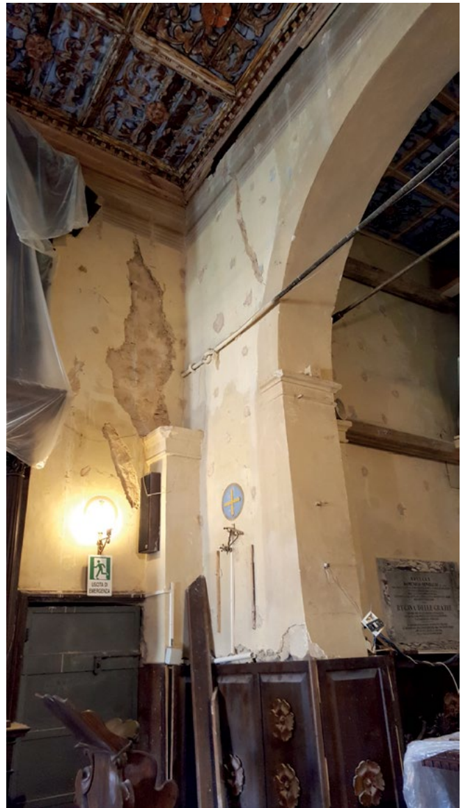
Figura 3. A sinistra la navata unica della chiesa; a destra il particolare della lesione in corrispondenza dell'arco dell'abside.
