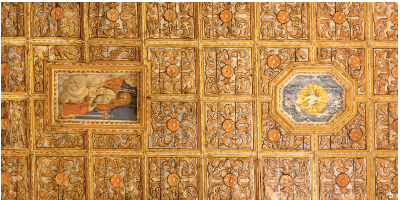
Figura 30. Prodotti fotogrammetrici. (a) Modello triangolato (mesh) ad altissima definizione del soffitto ligneo della chiesa di Santa Maria delle Grazie; (b) modello 3D texturizzato tramite proiezione dell'ortofoto (GSD pari a 1mm) che consente una lettura ad altissima risoluzione dei motivi dipinti dei lacunari.
