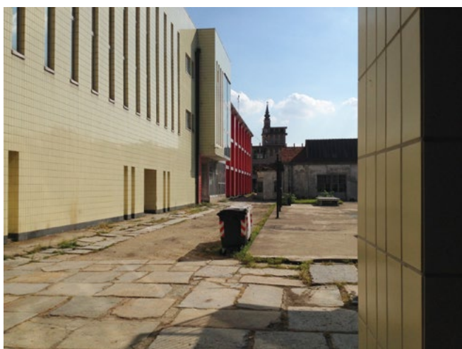
Figure 5-7. Vedute del complesso ristrutturato, fronte su corte interna (fotografie dell'Autrice, 2018).
