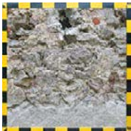
figg. 37-38 – Campione “F” 1x1m di tessitura muraria esterna, lato ovest della chiesa.
