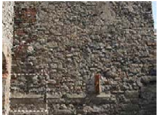
fig. 13 – Parete sud della cappella. Il tratteggio indica l'ingombro dell'apertura originaria.
