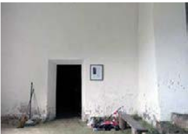
fig. 7 – L'ingresso alla cappella dall'atrio di connessione.
