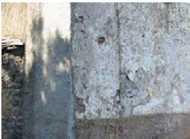
fig. 21 – Parete nord della cappella. Linea di accostamento delle due murature di epoche diverse, emersa attraverso l'intonaco a causa delle spinte orizzontali della cappella.
