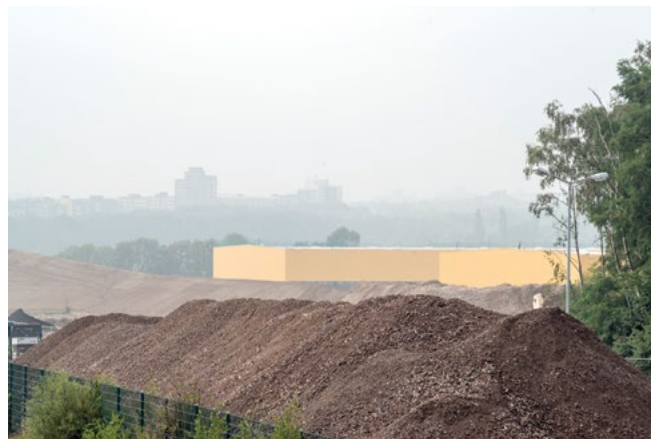
Figura 2. Bochum: veduta dell'ex area industriale Opel interessata da demolizioni e bonifiche dei terreni.
