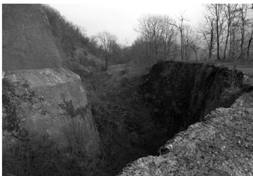
Fig. 15. I resti di uno degli orecchioni in roccia della tenaglia a protezione della cortina verso Stura del forte intermedio, con il fossato antistante.
