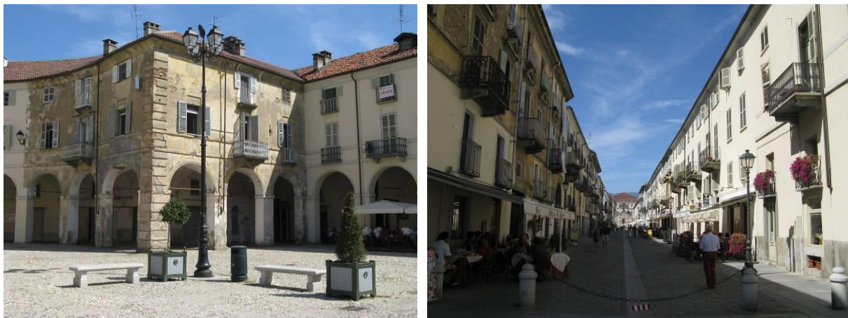
Fig. 1-2: Piazza dell'Annunziata and via Mensa after repaving work
