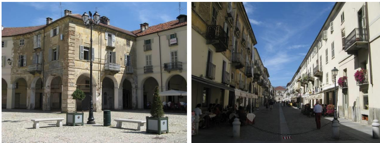
Fig. 1-2: Piazza dell'Annunziata and via Mensa after repaving work
