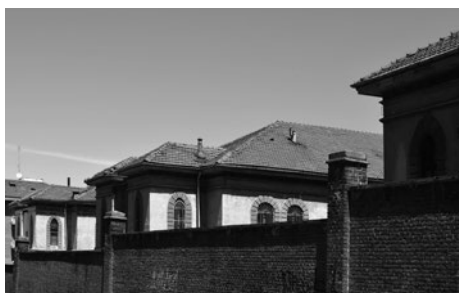
Fig. 51. I fabbricati della caserma Lamarmora su via Cardinal Maurizio.
