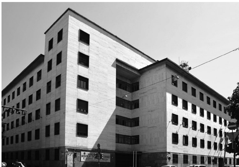
Fig. 10. L'edificio degli ex Alti Comandi.
