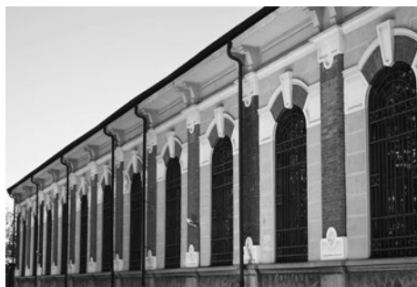
Fig. 30. Uno degli edifici delle cavallerizze.
