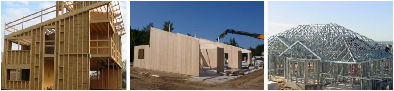
Figura 1. Metodologie di costruzione a secco: sistema balloon frame; sistema a pannelli Xlam; sistema steel frame.
