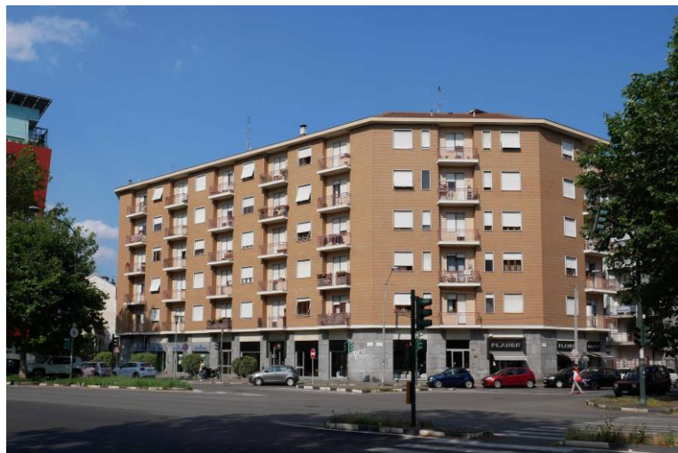
Fig. 5. Edificio residenziale multipiano appartenente al target di riferimento sito in Torino, Corso Siracusa
