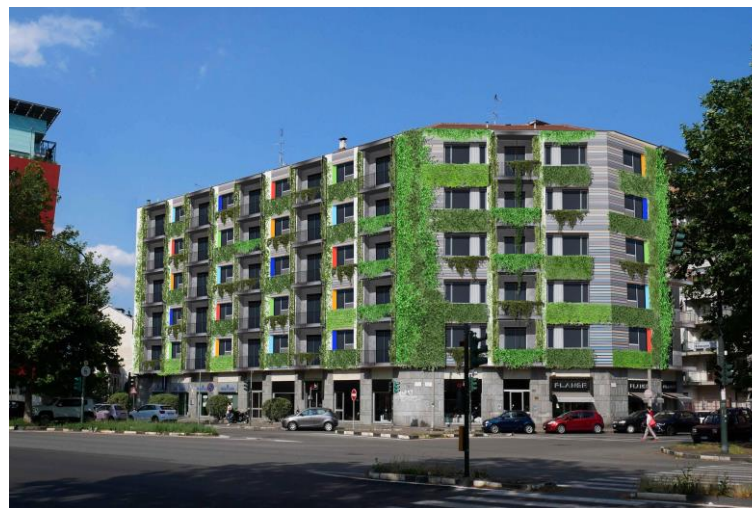
Fig. 6. Simulazione fotorealistica di nuovo involucro per l'edificio di Fig. 5 con tecnologie di inverdimento verticale
