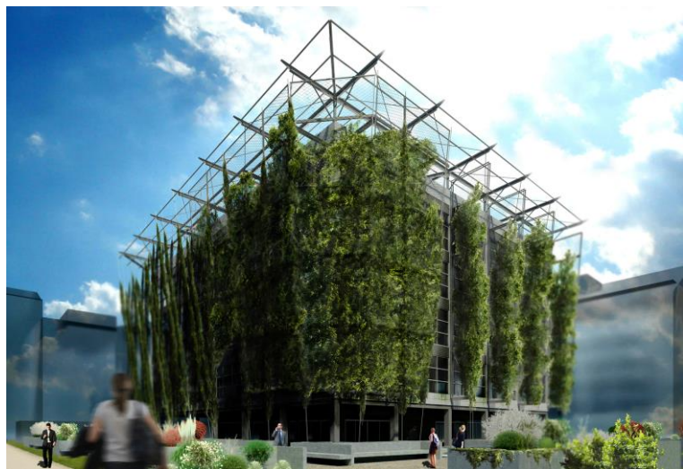
Fig. 7. Visualizzazione fotorealistica di un edificio multipiano ad uso scolastico con differenti tipologie di sistemi di schermature esterne vegetali
