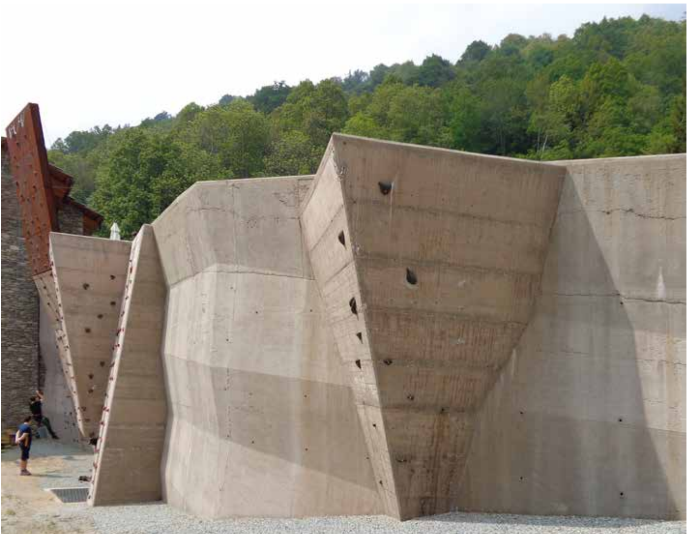
La parete di arrampicata è il segno ordinatore del Porto Ousitano di Ostana (fotografia di M. Crotti).
