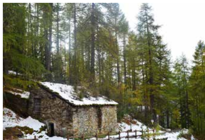
Chamois, un rudere lungo la strada per La Magdaleine: una futura “antenna” del nuovo centro civico?
