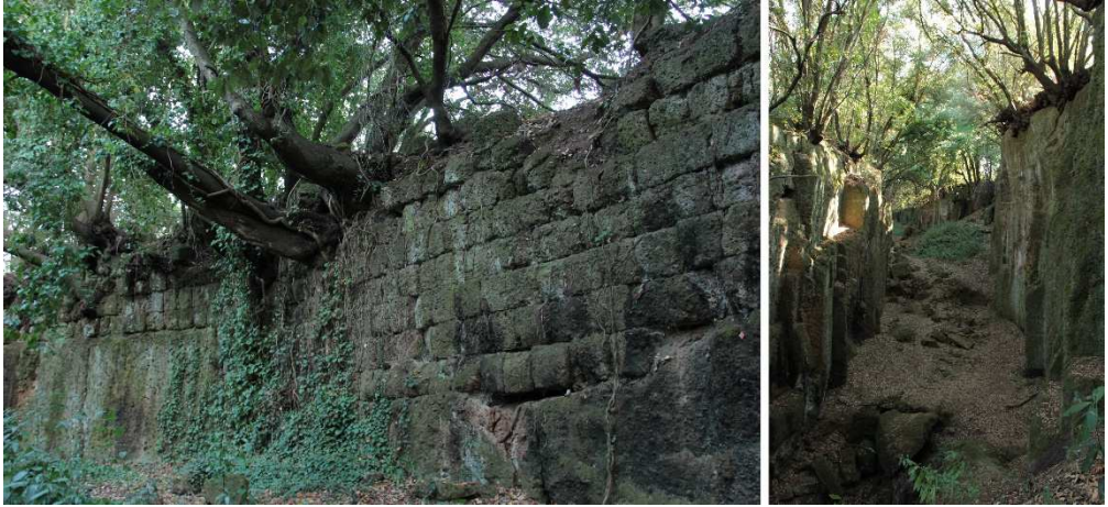
Fig. 4. A sinistra le mura semicostruite, a destra il fossato nel tratto verticalizzato.
