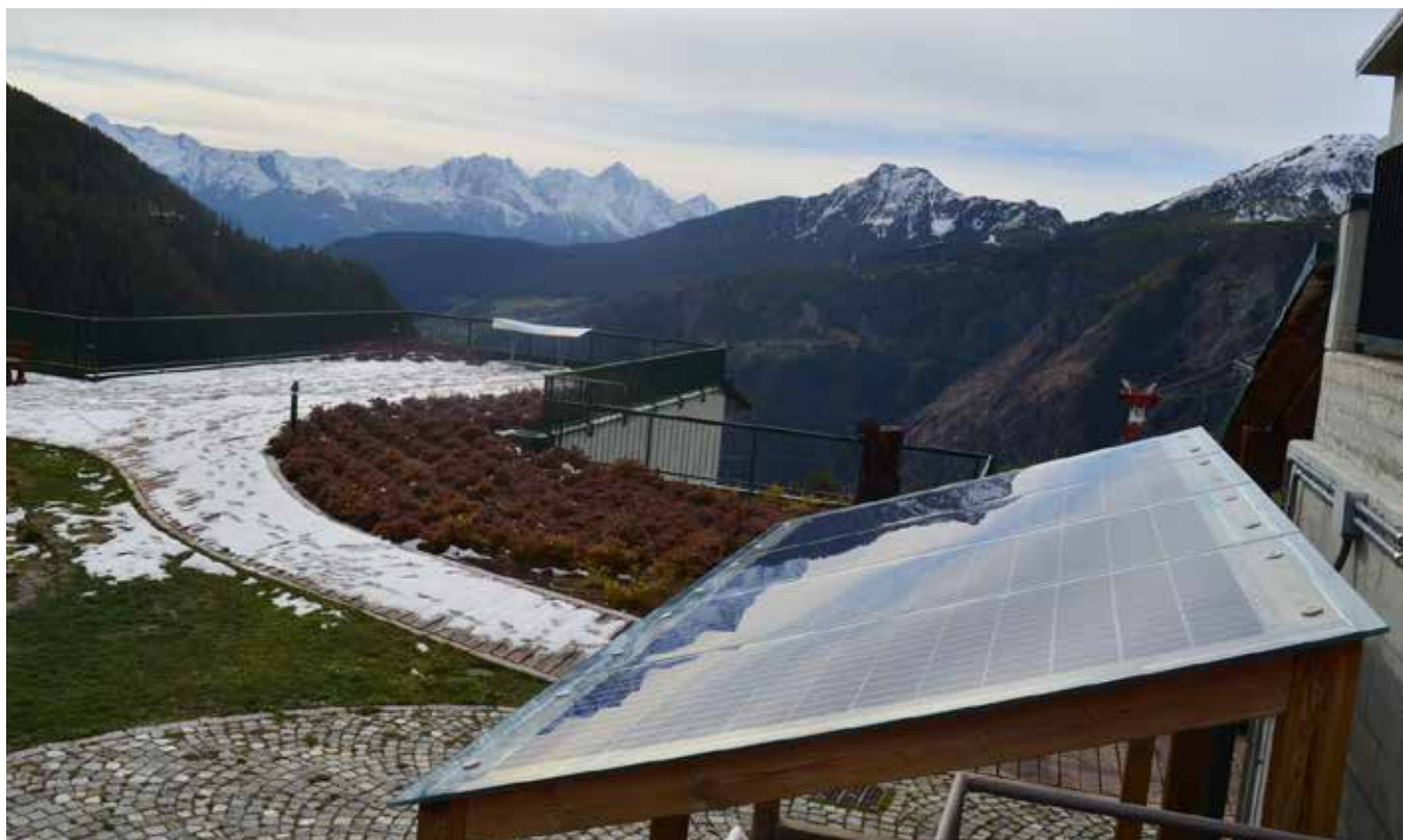
Chamois, spazi pubblici tra high-tech e soft-tech sulla copertura della funivia merci.
