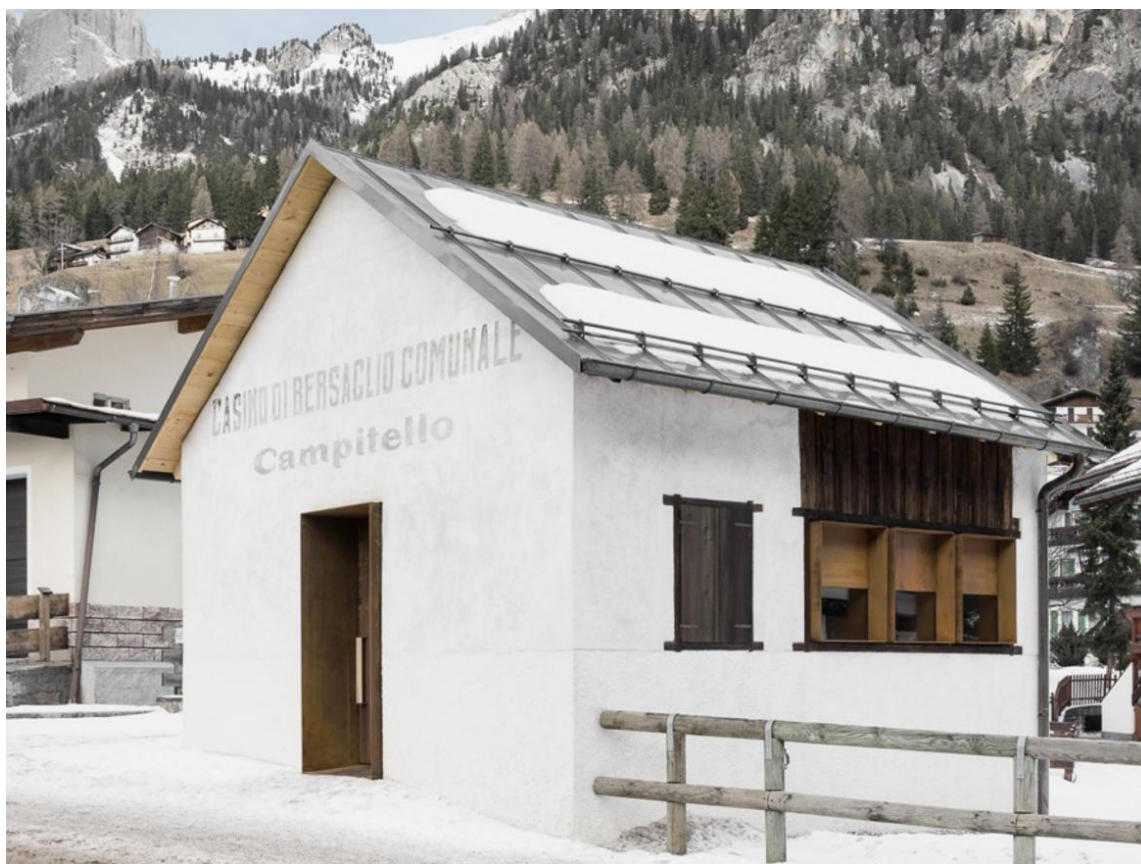
Fig. 5 – Restauro del Casino di Bersaglio Campitello, Campitello di Fassa, Weber+Winterle architetti. Progetto premiato alla rassegna Costruire il Trentino 2013-2016.
